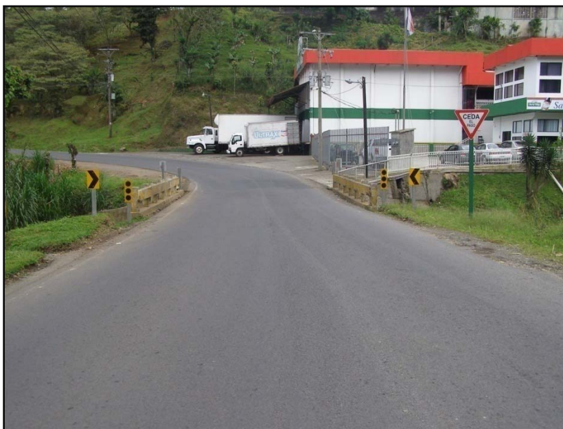
Figura 2. Vista a lo largo de la línea centro del puente sobre la Quebrada Palo. Estado del puente al 17 de noviembre de 2010.
