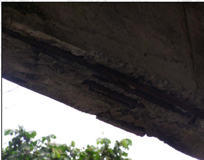
Figura 9. Detalle de viga exterior (aguas abajo) en la cual se observa desprendimiento de concreto y el acero de refuerzo expuesto y oxidado.
