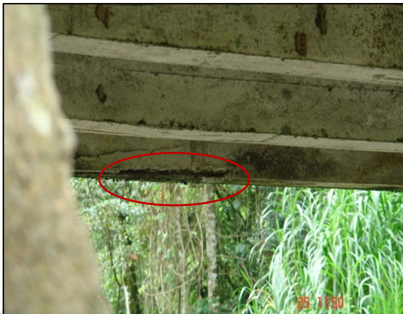
Figura 8. Vista de viga exterior (aguas abajo) en la cual se observa el desprendimiento del concreto y el acero de refuerzo expuesto con evidencia de oxidación.
