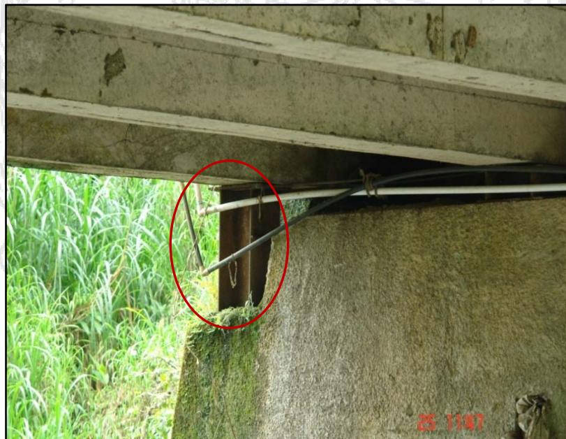
Figura 11. Vista de viga exterior (aguas abajo) apoyada sobre un elemento de acero.
