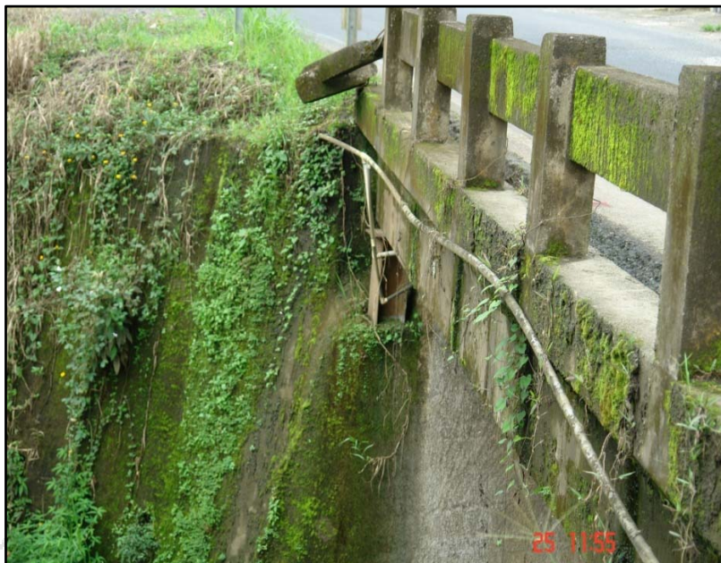
Figura 12. Vista del aletón izquierdo del bastión Noreste. Los ductos de drenaje se encuentran obstruidos con sedimentos y vegetación.
