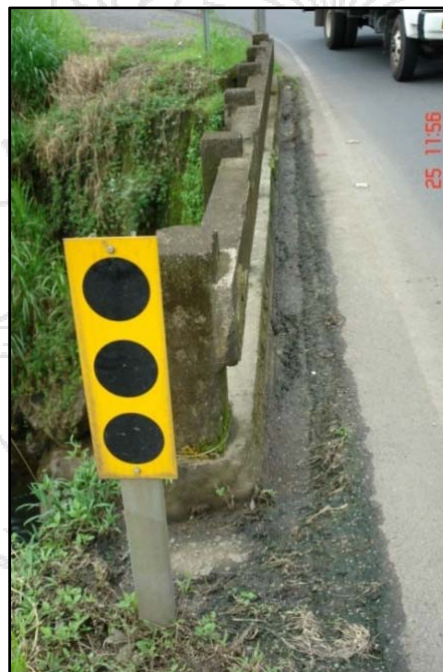
Figura 7. Obstrucción de los bordillos del puente por la acumulación de sedimentos.
