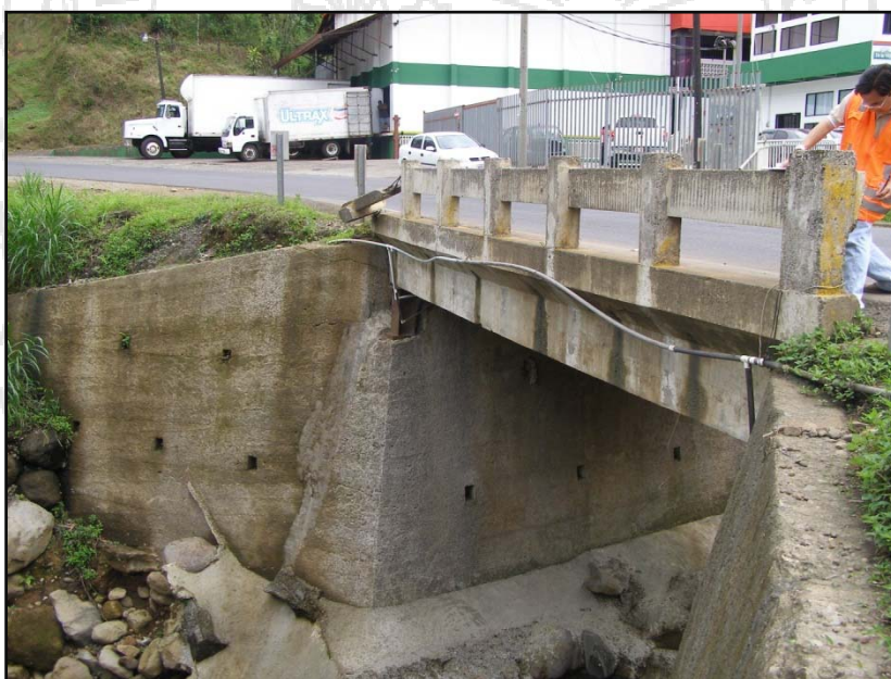
Figura 3. Vista lateral del puente sobre la Quebrada Palo. Estado del puente al 17 de noviembre de 2010.
