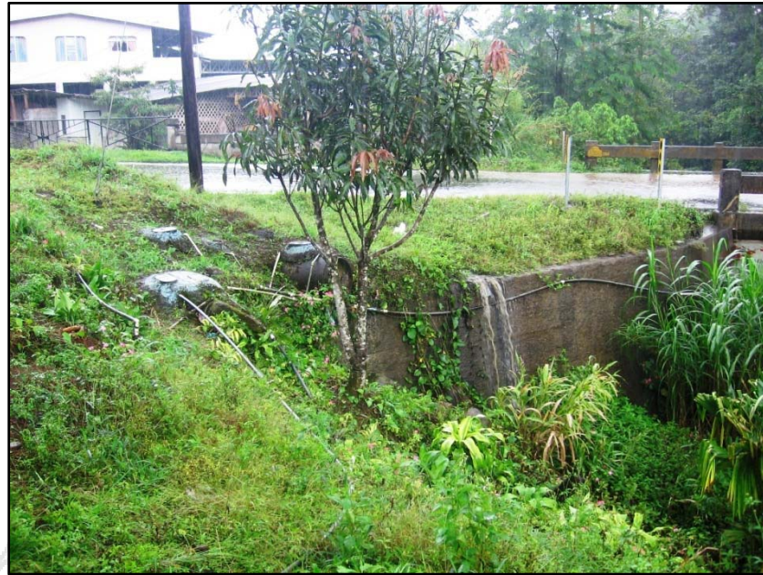
Figura 6. Descarga del agua directamente sobre los aletones.
