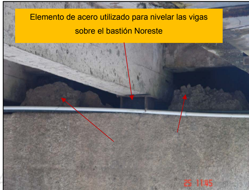
Figura 10. Viga apoyada sobre elementos de acero y acumulación de sedimentos en la zona de los apoyos.
