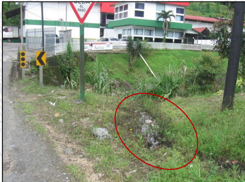
Figura 5. Ausencia de un sistema adecuado de drenaje en los accesos.
