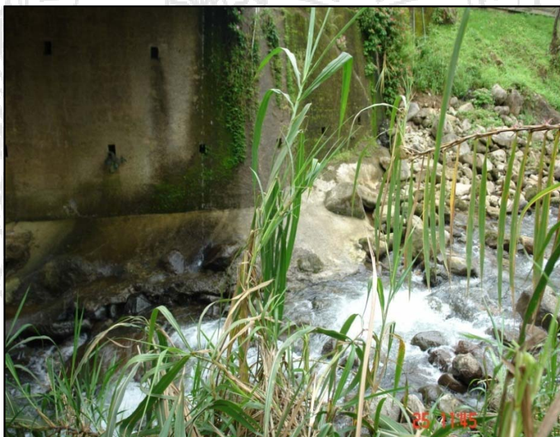
Figura 13. Vista de la base del bastión Noreste. Se observa indicios de socavación del bastión.
