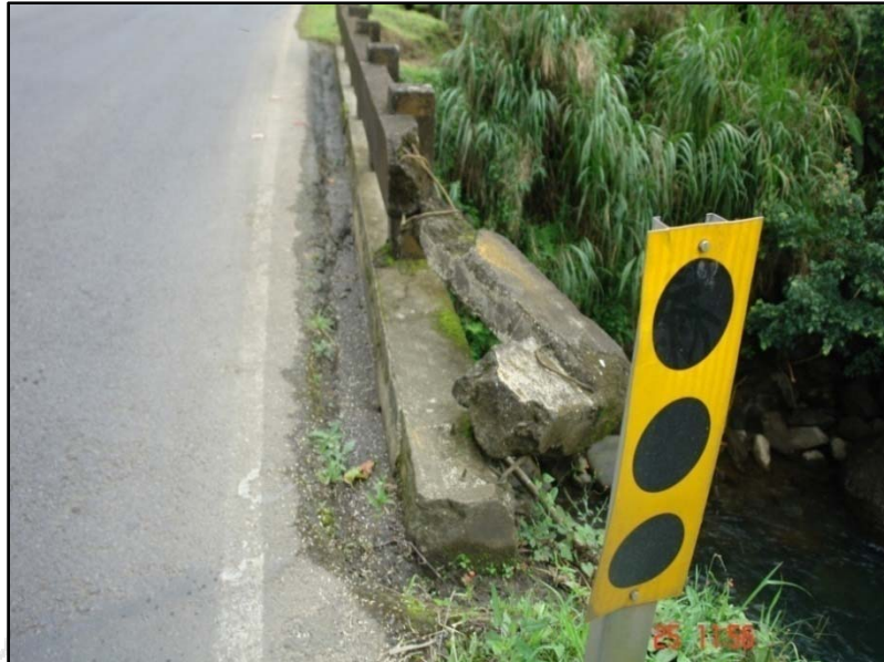
Figura 4. Daño observado en la baranda de concreto.
