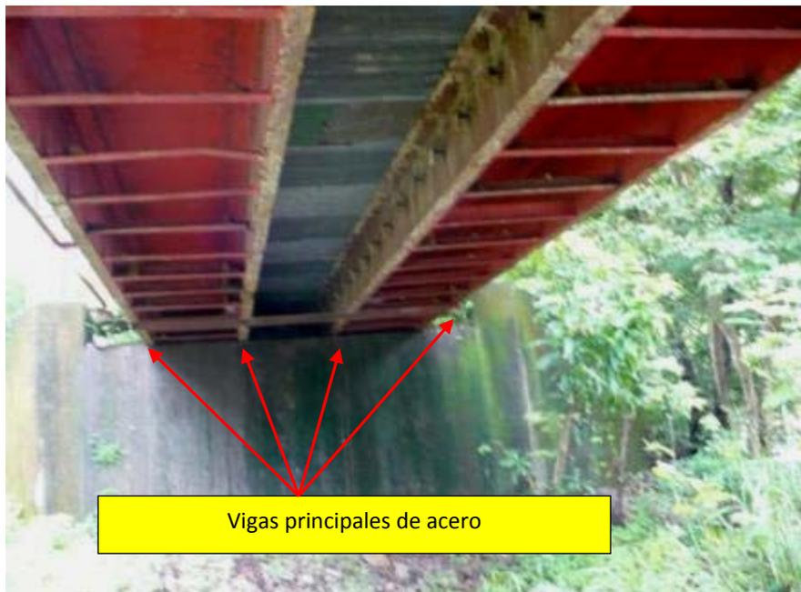
**Figura 3.** Vista inferior hacia el bastión Sur mostrando las vigas armadas de acero en el bastión Sur.
