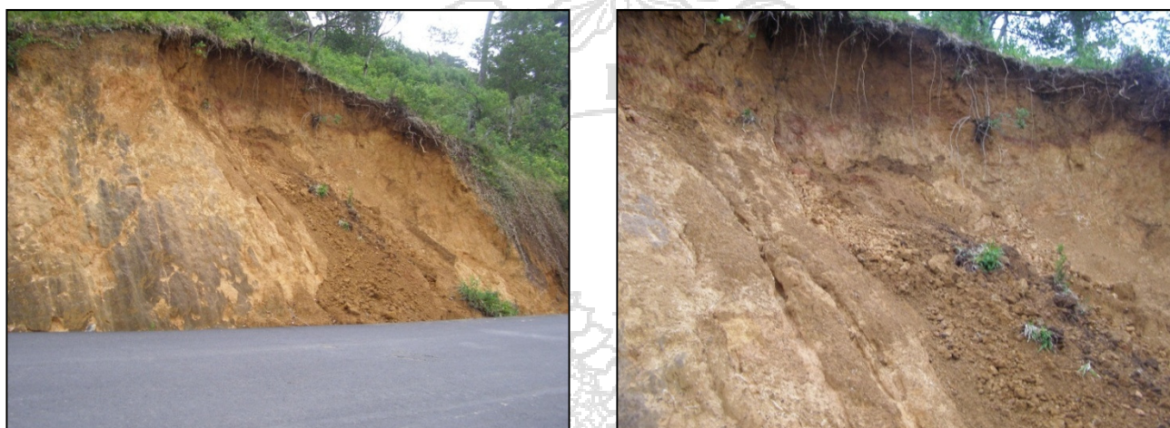
Figura 19. Deslizamientos registrados en estacionamiento 29+600.
