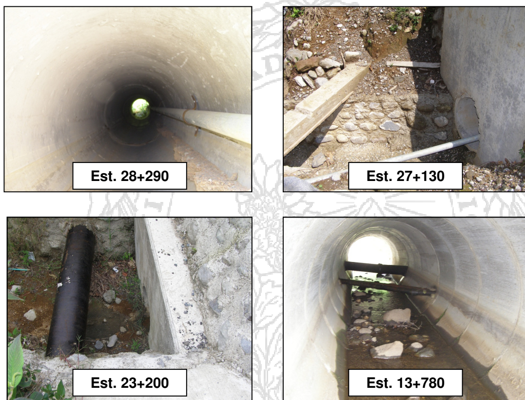
Figura 16. Alcantarillas con tuberías que las atraviesan. Estado de las estructuras al 17 de mayo de 2011.
