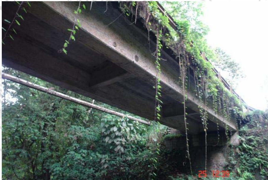
Figura 8. Vegetación presente en la superestructura y sobre los bastiones.
