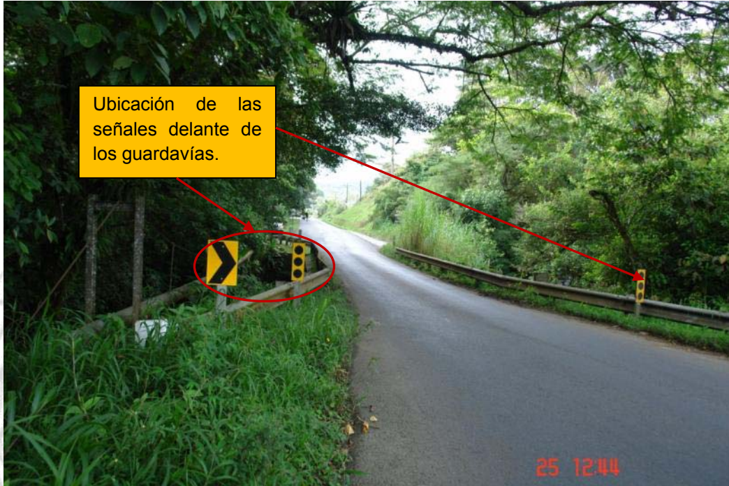
Figura 5. Colocación inadecuada de las señales y estado de la demarcación horizontal
