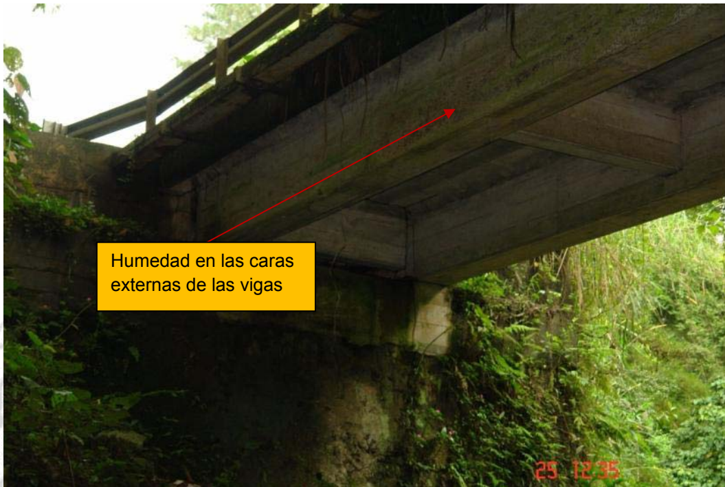
Figura 7. Evidencia de humedad en las caras externas de la viga y sobre los bastiones.
