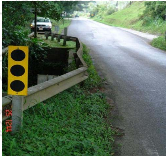
Figura 4. Daño en la baranda.
