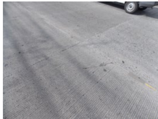
Figura 12: Agrietamiento en est. 0+670, sentido Zapote – San Francisco (izq.); agrietamiento en est. 0+314, sentido San Francisco – La Colina, con la losa superior derecha mostrando desgaste (der.); año 2015.
