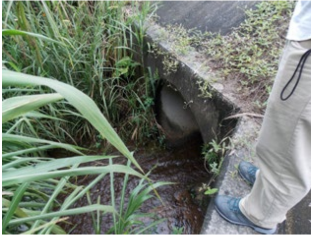
Figura 1. Alcantarilla doble con uno de sus conductos obstruidos (izq.), est. 12+400; grietas entre el pavimento y la cuneta del muro de contención en el est. 16+850 (der.), año 2015.
