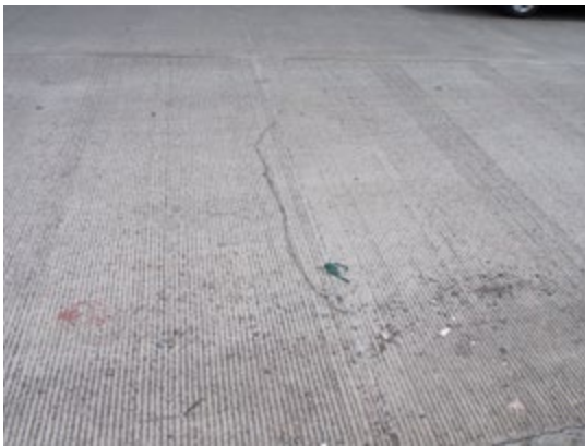
Figura 12: Agrietamiento en est. 0+670, sentido Zapote – San Francisco (izq.); agrietamiento en est. 0+314, sentido San Francisco – La Colina, con la losa superior derecha mostrando desgaste (der.); año 2015.
