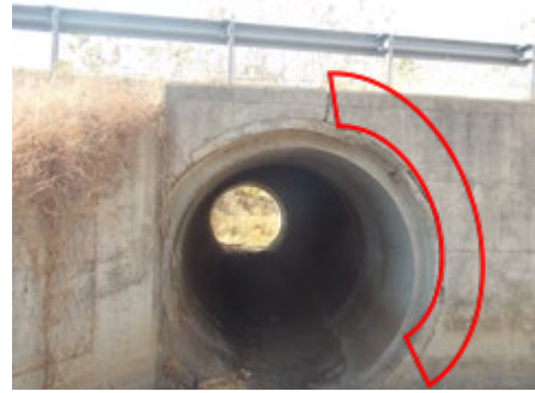
Figura 7: Socavación a la salida de la alcantarilla, est. 1+070 (izq.); agrietamiento en el concreto en la entrada, alcantarilla de la est. 4+820, tal y como se encontraron en el año 2016.
