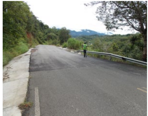
Figura 2. Cuneta revestida y parcialmente obstruida por vegetación, est. 18+650 (izq.); hundimiento de la superficie de ruedo y bache en las inmediaciones del muro de contención en el est. 24+300, junto con una muestra de guardavías usados como barandas (der.), año 2015.
