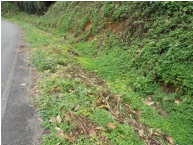
Figura 2. Cuneta revestida y parcialmente obstruida por vegetación, est. 18+650 (izq.); hundimiento de la superficie de ruedo y bache en las inmediaciones del muro de contención en el est. 24+300, junto con una muestra de guardavías usados como barandas (der.), año 2015.
