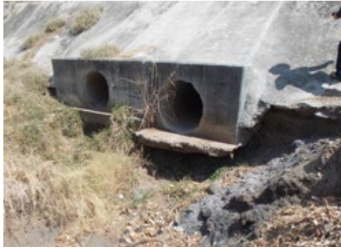
Figura 7: Socavación a la salida de la alcantarilla, est. 1+070 (izq.); agrietamiento en el concreto en la entrada, alcantarilla de la est. 4+820, tal y como se encontraron en el año 2016.
