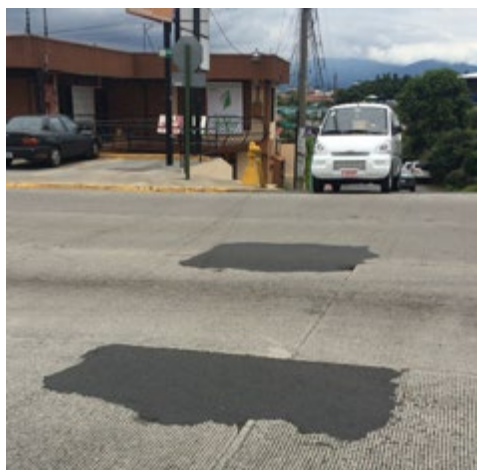
Figura 13: Reparaciones con asfalto en est. 0+733, sentido San Francisco – La Colina (izq.); aproximación al puente sobre el Río María Aguilar, sentido Zapote – San Francisco (der.); año 2017.
