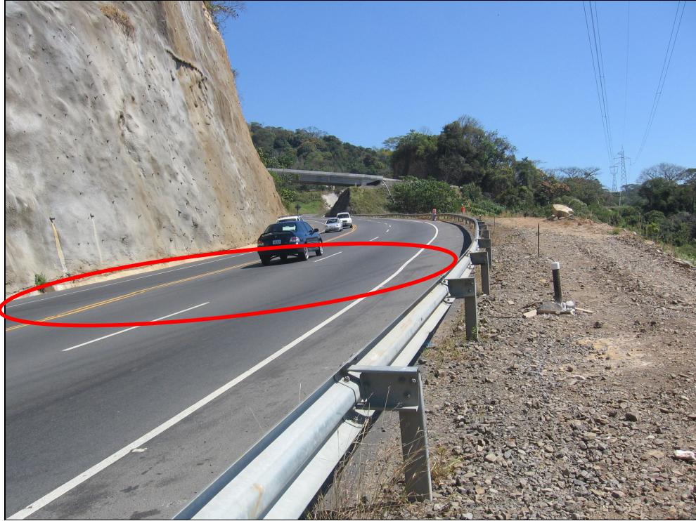
Figura 13. Presencia de un desnivel en la carpeta; vista parcial del terraplén. (al 19 de enero de 2011).
