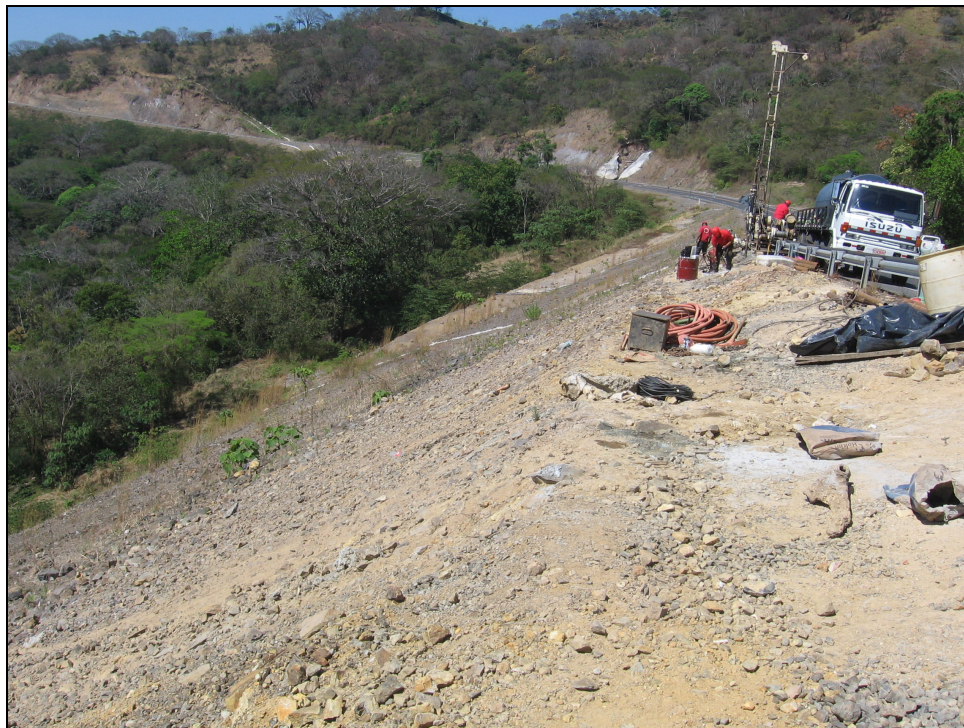
Figura 9. Vista del terraplén en Km 38+800. (al 19 de enero de 2011).
