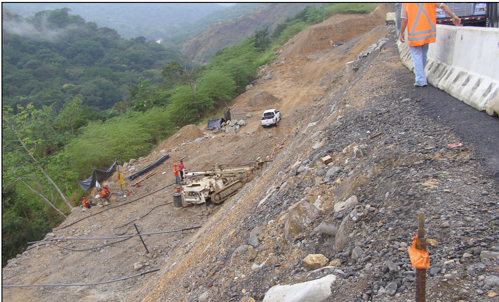
Figura 1. Estado de terraplén en el Km 46+800 a noviembre de 2010.
