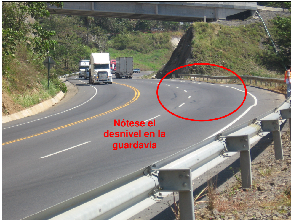
Figura 11. Movimiento de terraplén. (al 19 de enero de 2011).
