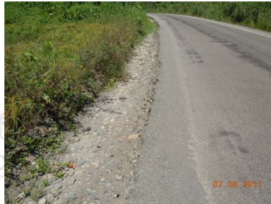
Figura 12. Estación 2+200: pérdida de borde de calzada y exudación
