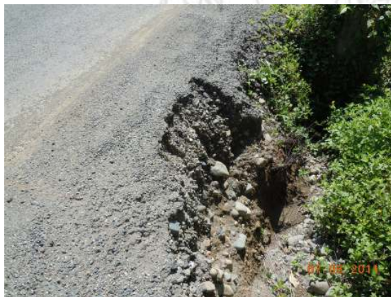
Figura 13. Estación 2+200: pérdida de borde de calzada, exudación y agregado expuesto
