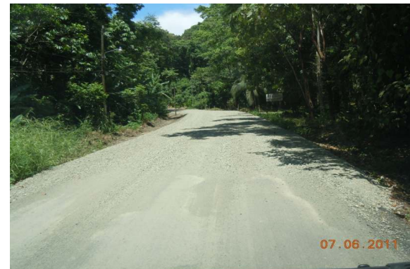
N°78 Estación 15+400, hacia Manzanillo. Termina superficie con capa asfáltica delgada e inicia lastre.
