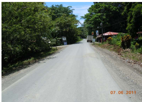
N°73 Estación 13+600, hacia Manzanillo. Termina superficie con lastre e inicia capa asfáltica delgada
