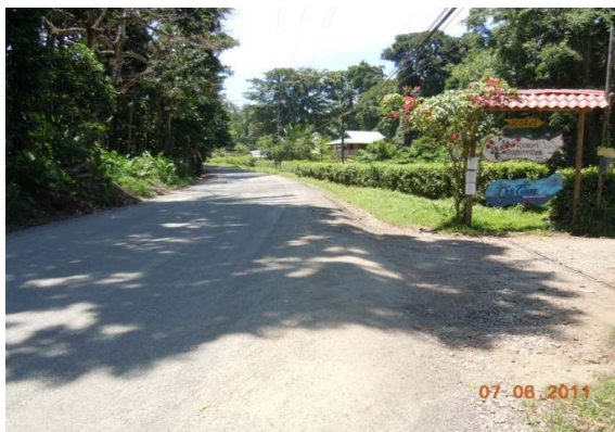
N°49 Estación 9+500, hacia Manzanillo. Inicia otro tipo de tratamiento superficial Material de secado para el tratamiento superficial
