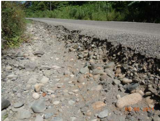
Figura 12. Estación 2+200: pérdida de borde de calzada y exudación
