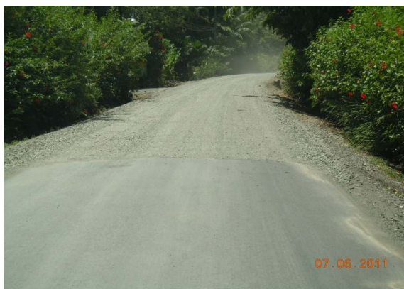
N°67 Estación 12+000, hacia Manzanillo. Termina superficie con capa asfáltica delgada e inicia lastre
