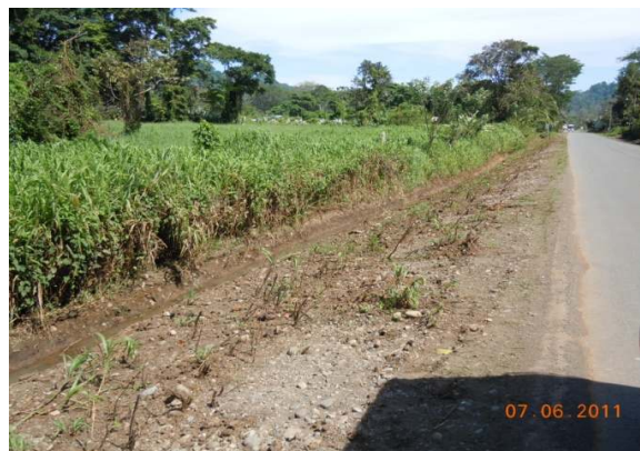
N°2 Estación 0+300, hacia Hone Creek. Superficie con capa asfáltica delgada. Cuneta inadecuada_agua estancada. Material suelto que por la lluvia puede obstruir la cuneta.
