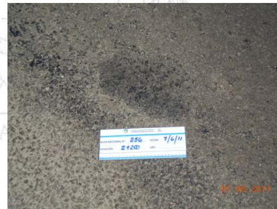
Figura 13. Estación 2+200: pérdida de borde de calzada, exudación y agregado expuesto
