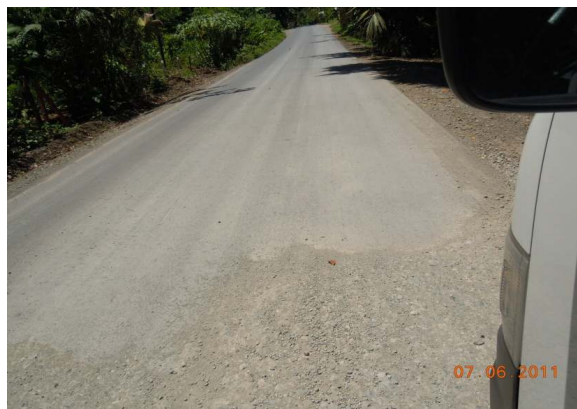
N°68 Estación 12+400, hacia Manzanillo. Termina superficie con lastre e inicia capa asfáltica delgada
