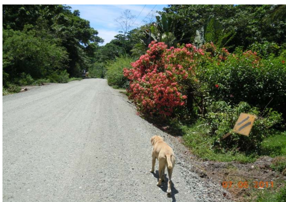
N°71 Estación 13+400, hacia Manzanillo. Superficie con lastre. Señal de puente angosto caída
