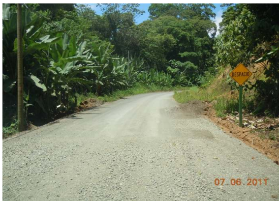
N°79 Estación 15+600, hacia Manzanillo. Termina superficie con lastre e inicia tratamiento superficial
