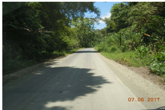
N°77 Estación 15+000, hacia Manzanillo. Termina superficie con lastre e inicia capa asfáltica delgada.
