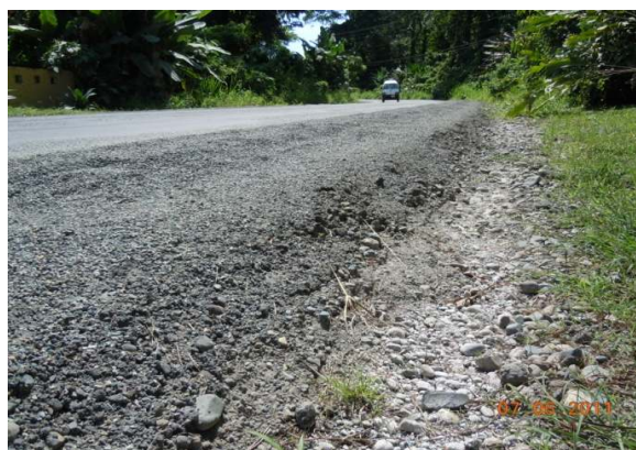
N°11 Estación 2+000, hacia Manzanillo. Superficie con tratamiento superficial. Material de secado en el borde de calzada.
