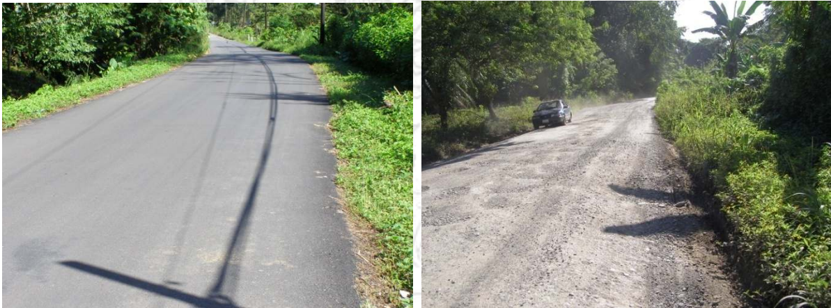
Figura 2. Diferentes condiciones de superficie de rodamiento, Sobre-capa asfáltica y superficie de lastre.
