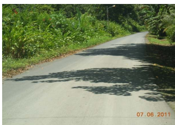
N°83 Estación 16+600, hacia Manzanillo. Termina superficie con lastre e inicia capa asfáltica delgada
