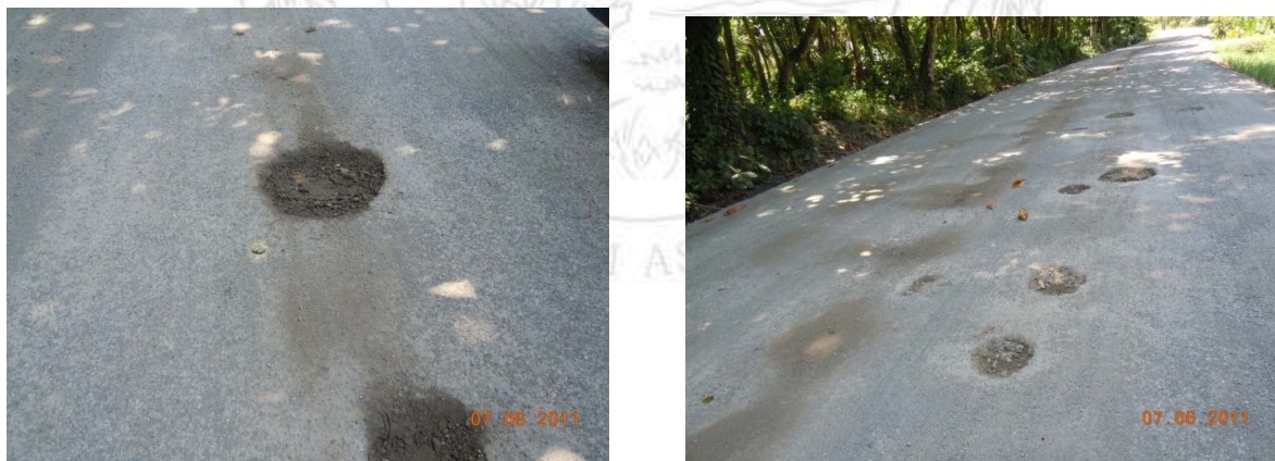
Figura 17. Estación 9+650: huecos y agregado expuesto. (Fecha de fotografías 7-jun-2011) (Fuente: Pitra-LanammeUCR)
