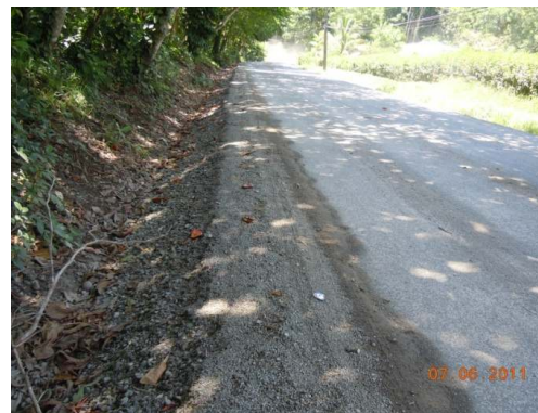
N°5 Estación 9+650, hacia Manzanillo. Material de secado producto del proceso constructivo del tratamiento superficial
