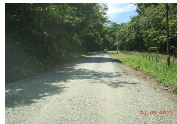
N°75 Estación 14+200, hacia Manzanillo. Termina superficie con lastre e inicia capa asfáltica delgada
