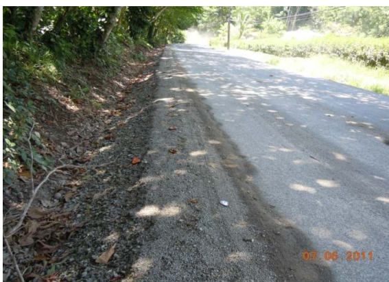
N°52 Estación 9+650, hacia Manzanillo. Superficie con tratamiento superficial. Material de secado para el tratamiento superficial.
