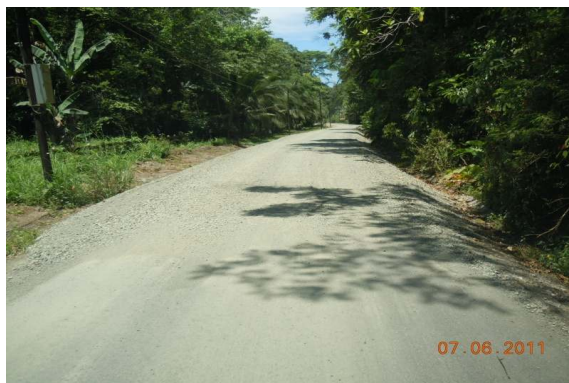
N°76 Estación 14+600, hacia Hone Creek. Termina superficie con capa asfáltica delgada e inicia lastre.
