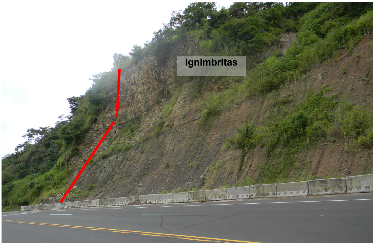
Figura 26: Talud, est. 48+430; la línea roja indica el perfil aproximado.
