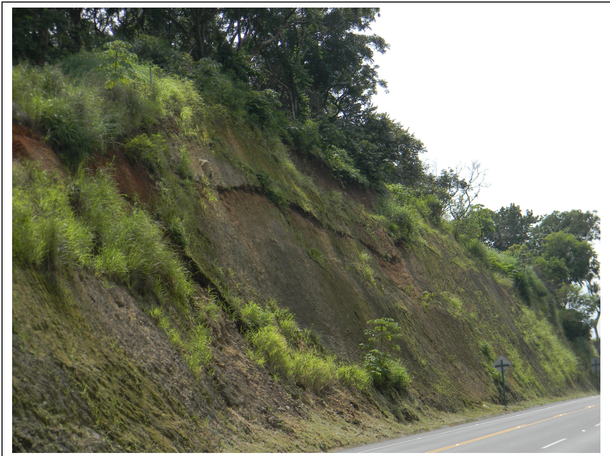
Figura 2: Talud izquierdo, est. 28+400.
