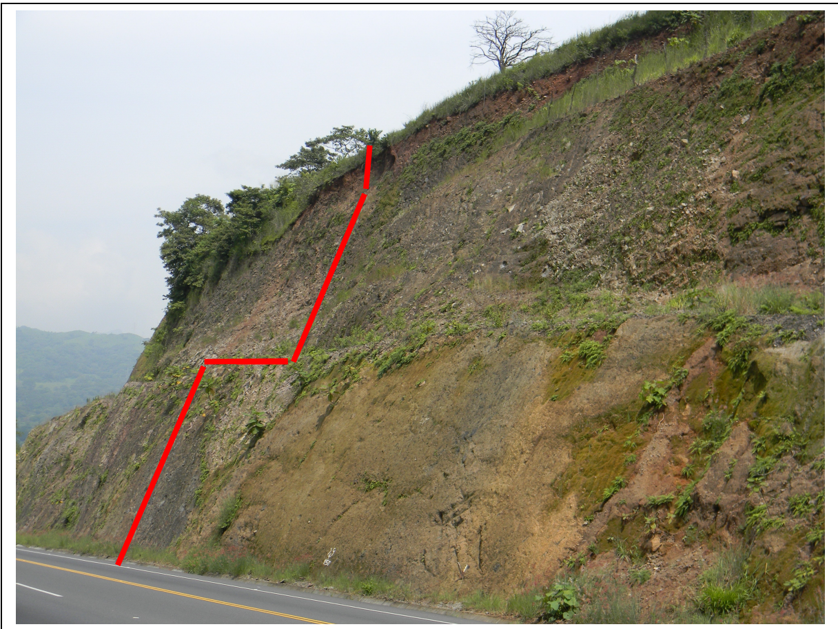
Figura 5: Talud, est. 29+050; la línea roja indica el perfil aproximado.
