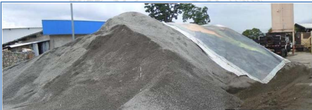
Fotografía 8 Lonas para protección de apilamientos de agregados
