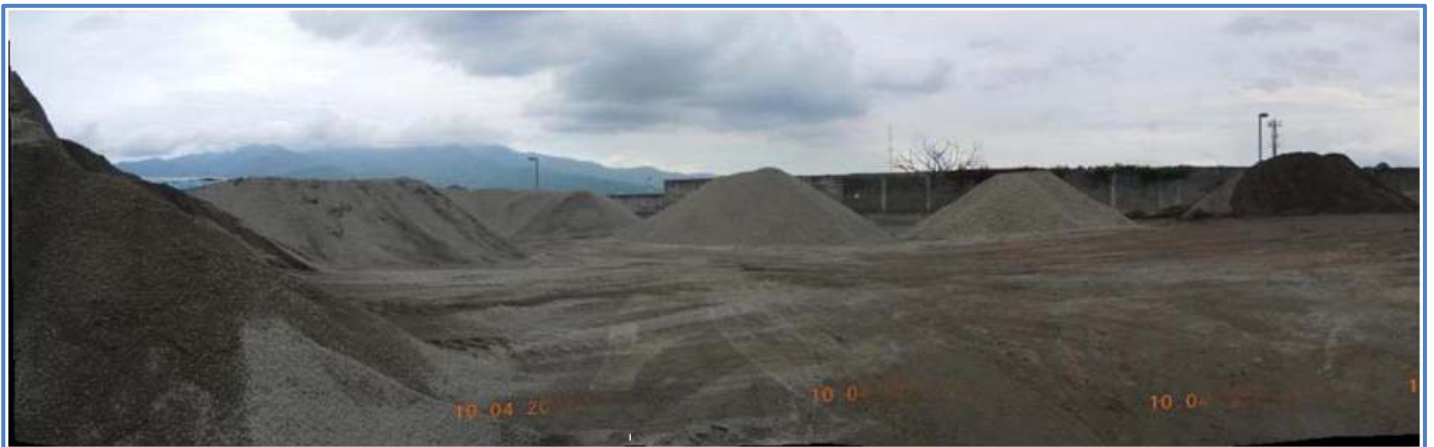
Fotografía 7 Zona de apilamientos de agregados
