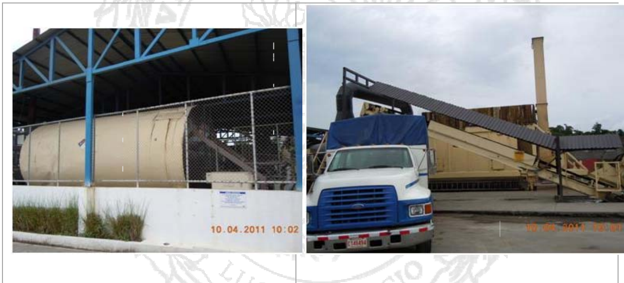
Fotografía 6 Zona bajo techo en donde se ubican los tanques de almacenamiento de cemento asfáltico, combustibles y otros. Estructura techada para protección de banda agregados.
