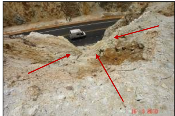
Fotografías 11 y 12. Talud afectado por hidrotermalismo en Estacionamiento 48+550. Condiciones al 16 de marzo de 2010. (LanammeUCR, 2010).
