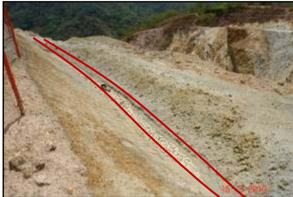
Fotografías 13, y 14. Canales de drenaje no impermeabilizados en Estacionamiento 48+550. Condiciones al 16 de marzo de 2010. (LanammeUCR, 2010).
