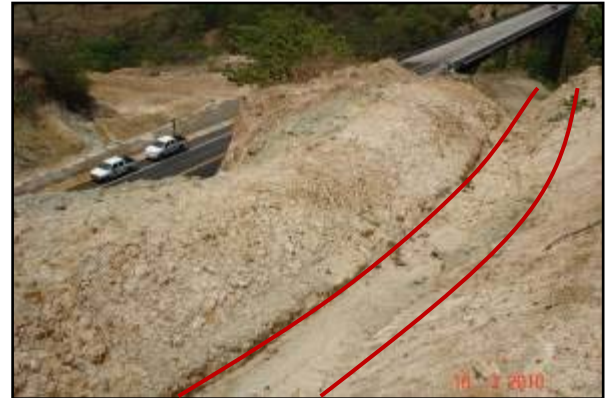
Fotografías 13, y 14. Canales de drenaje no impermeabilizados en Estacionamiento 48+550. Condiciones al 16 de marzo de 2010. (LanammeUCR, 2010).
