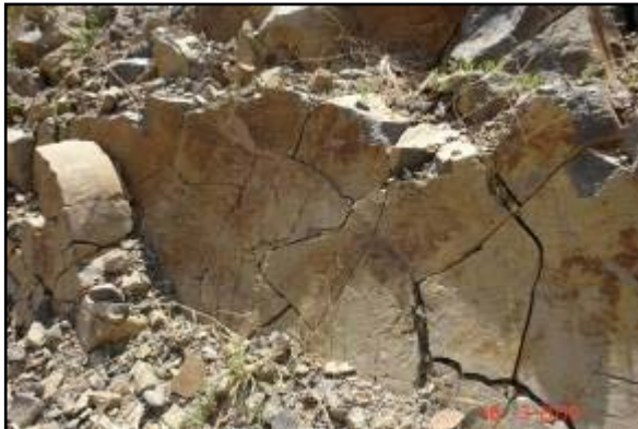
Fotografías 17 y 18. Fracturación del macizo que conforma el talud en Estacionamiento 49+100. Condiciones al 16 de marzo de 2010. (LanammeUCR, 2010).
