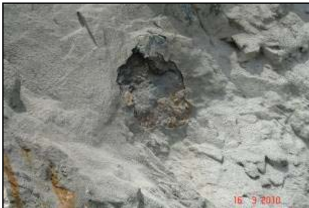
Fotografías 5,6, y 7. Talud con evidencia de desprendimiento de concreto lanzado. Condiciones al 16 de marzo de 2010. (LanammeUCR, 2010).
