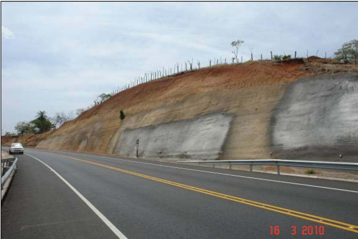
Fotografía 2. Talud tratado con concreto lanzado y drenes en Estacionamiento 41+750. Condiciones al 16 de marzo de 2010. (LanammeUCR, 2010).
