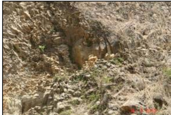
Fotografías 17 y 18. Fracturación del macizo que conforma el talud en Estacionamiento 49+100. Condiciones al 16 de marzo de 2010. (LanammeUCR, 2010).
