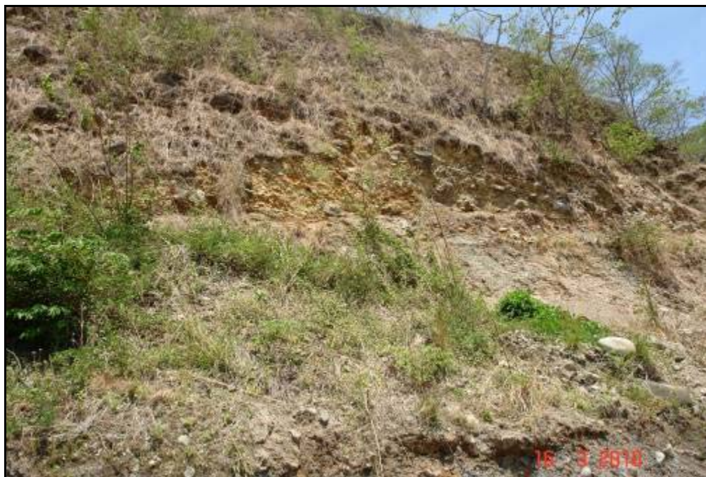
Fotografía 19. Evidencia de hidrotermalismo en talud en Estacionamiento 49+100. Condiciones al 16 de marzo de 2010. (LanammeUCR, 2010).
