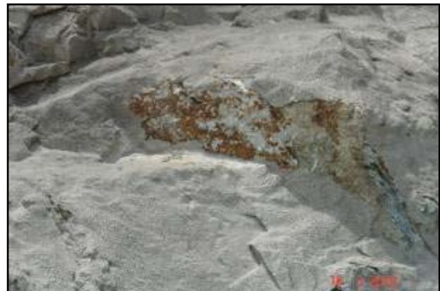
Fotografías 5,6, y 7. Talud con evidencia de desprendimiento de concreto lanzado. Condiciones al 16 de marzo de 2010. (LanammeUCR, 2010).
