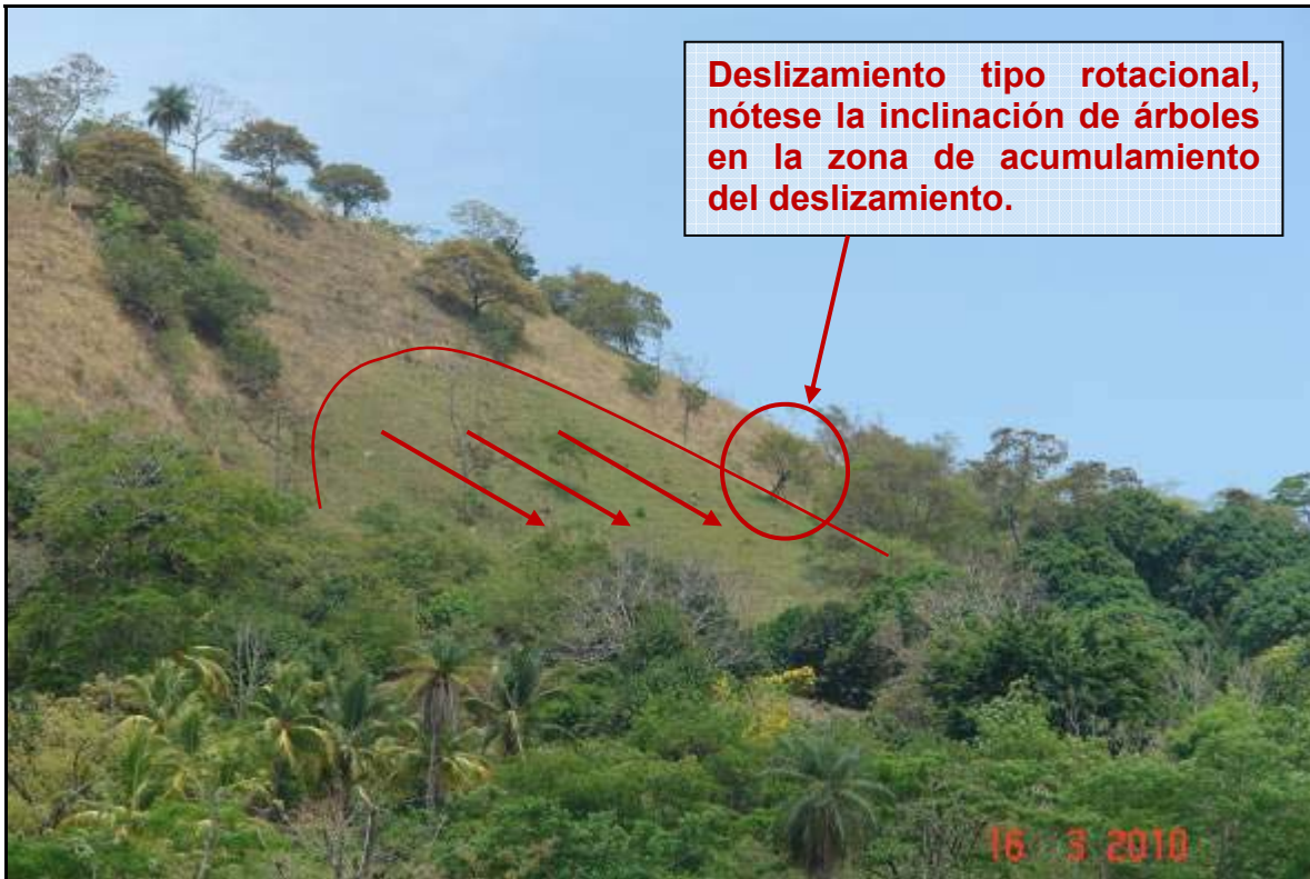
Fotografía 3. Deslizamiento en Estacionamiento 44+850. Condiciones al 16 de marzo de 2010. (LanammeUCR, 2010).
