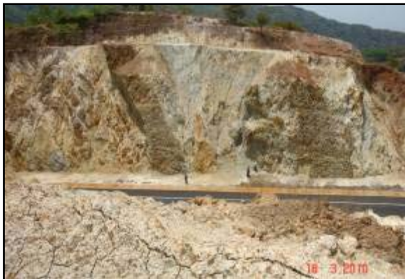
Fotografías 11 y 12. Talud afectado por hidrotermalismo en Estacionamiento 48+550. Condiciones al 16 de marzo de 2010. (LanammeUCR, 2010).
