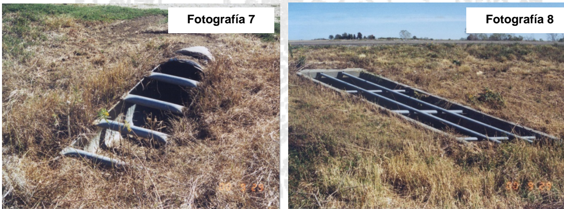
Fotografía 7 y 8. Ejemplos de elementos de entrada y salida de drenaje con diseño traspasable. Fuente: Roadside Design Guide, AASHTO 2002.
