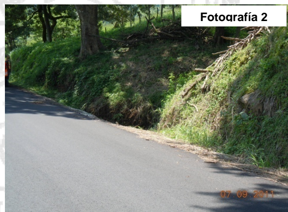
Fotografía 1 y 2. Secciones del proyecto sin barreras de contención lateral Fecha: 07/09/2011
