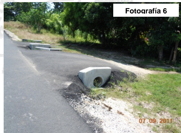
Fotografía 5 y 6. Cabezales de alcantarillas en entradas a casas. Fecha: 07/09/2011
