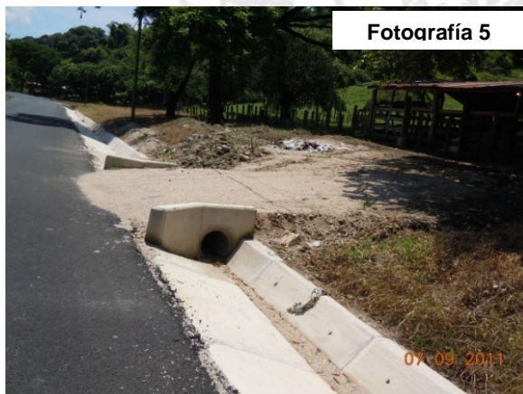
Fotografía 5 y 6. Cabezales de alcantarillas en entradas a casas. Fecha: 07/09/2011
