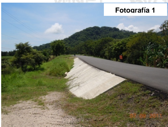
Fotografía 1 y 2. Secciones del proyecto sin barreras de contención lateral Fecha: 07/09/2011
