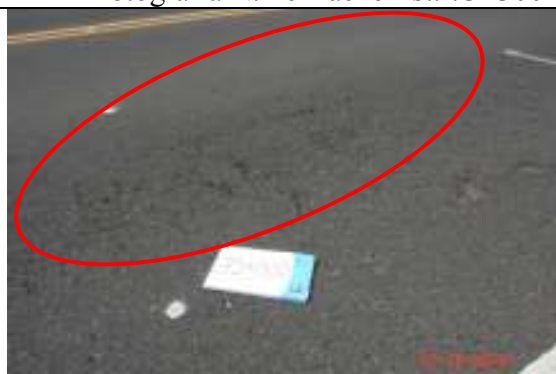
Fotografía N. 28 Desprendimiento Est. 73+000
