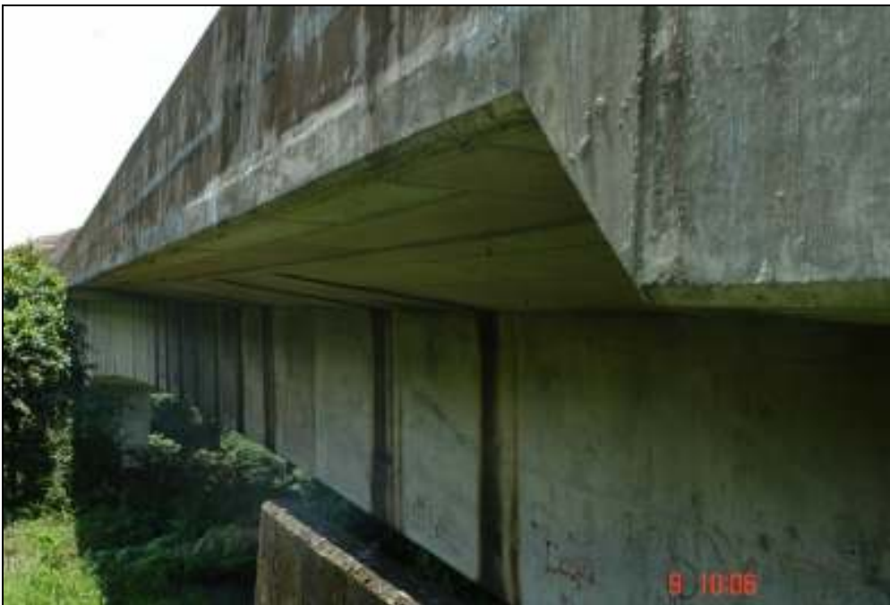
Imagen 9 Puente sobre el Río Concepción.
