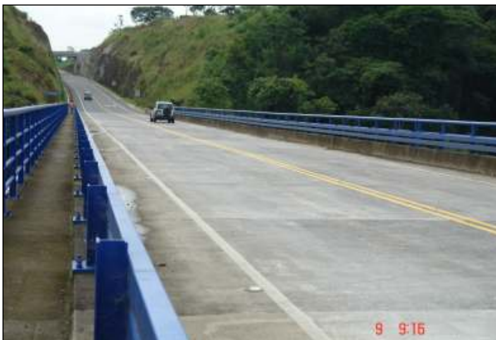
Imagen 5 Puente sobre el Río Ciruelas.
