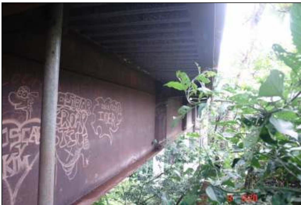
Imagen 6 Puente sobre el Río Ciruelas
