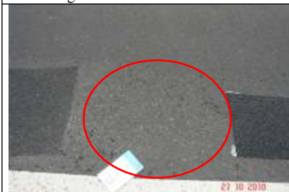
Fotografía N. 27 Desprendimiento Est. 66+000
