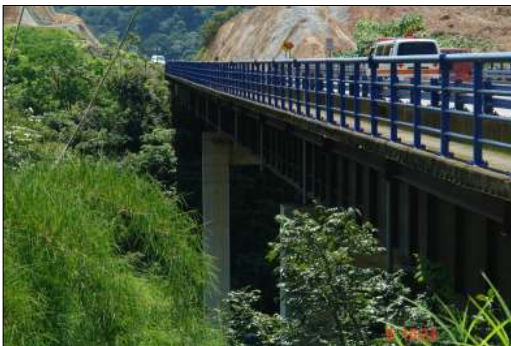
Imagen 11 Puente sobre el Río Salitral.
