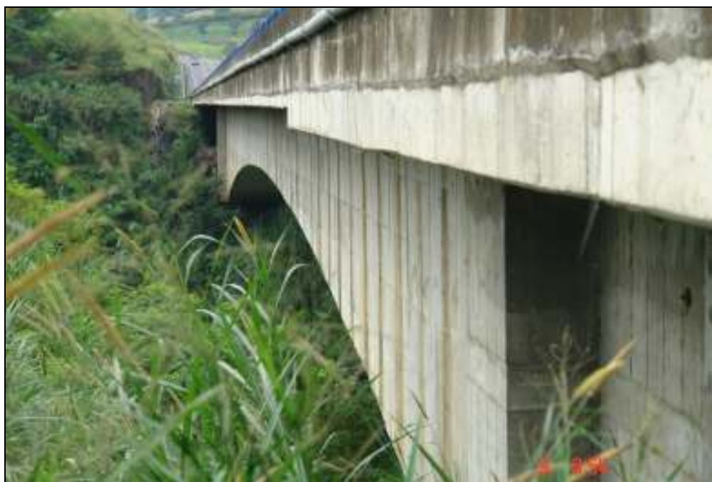
Imagen 4 Puente sobre el Río Virilla.
