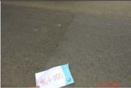
Fotografía N. 17c Desprendimiento Est. 46+000
