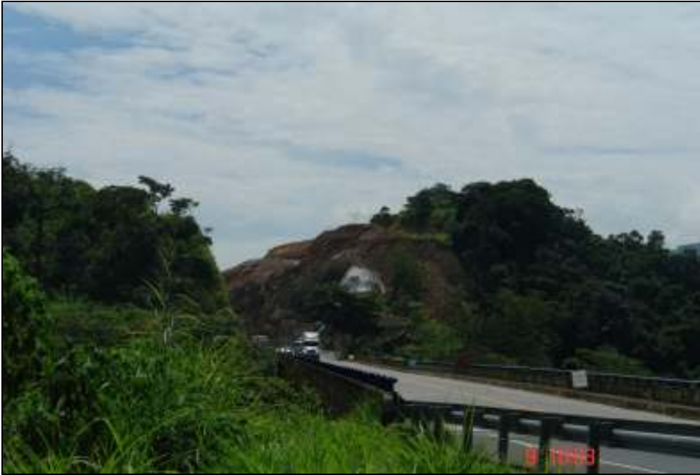
Imagen 8 Puente sobre el Río Concepción.
