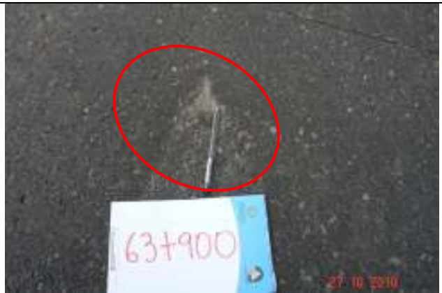
Fotografía N. 30 Desprendimiento Est. 63+000
