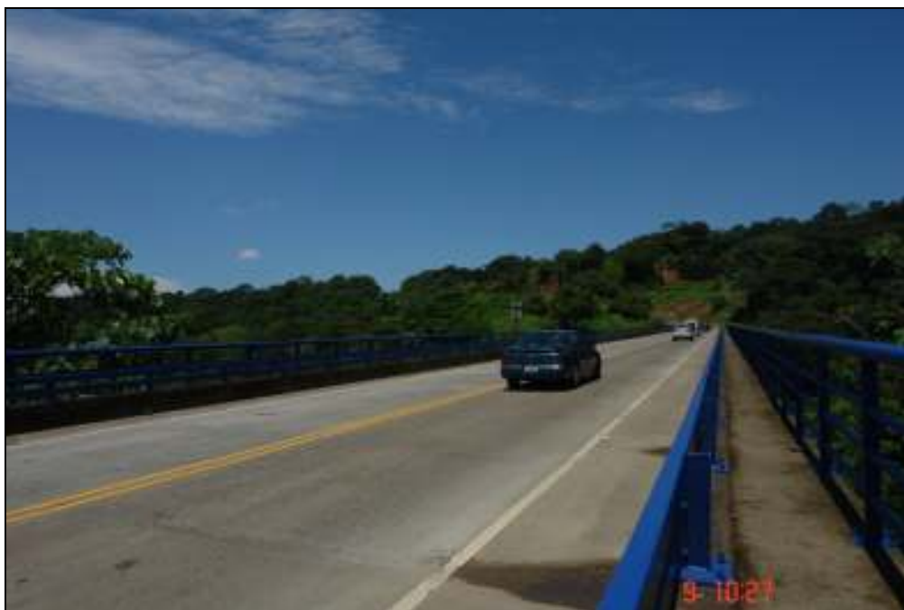
Imagen 10 Puente sobre el Río Salitral.
