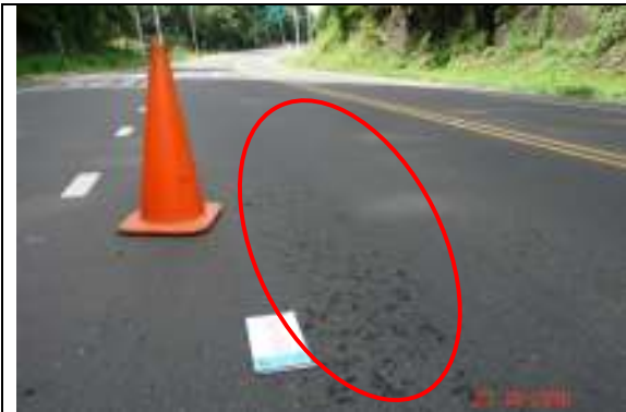
Fotografía N. 29 Desprendimiento Est. 76+000
