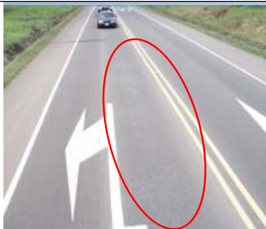
Fotografía N. 34 Fisuramiento Est. 68+300
