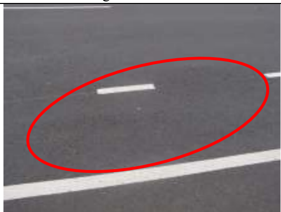
Fotografía N. 6 Desprendimiento Est. 12+800
