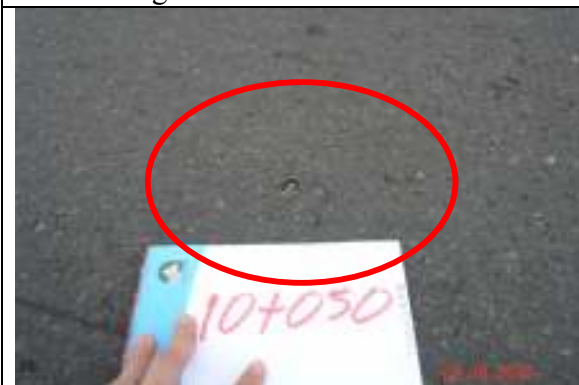
Fotografía N. 5 Desprendimiento Est. 10+050
