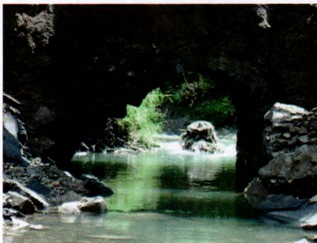
Figura 3. Base de la alcantarilla de arco de mampostería en la Quebrada Rivera
