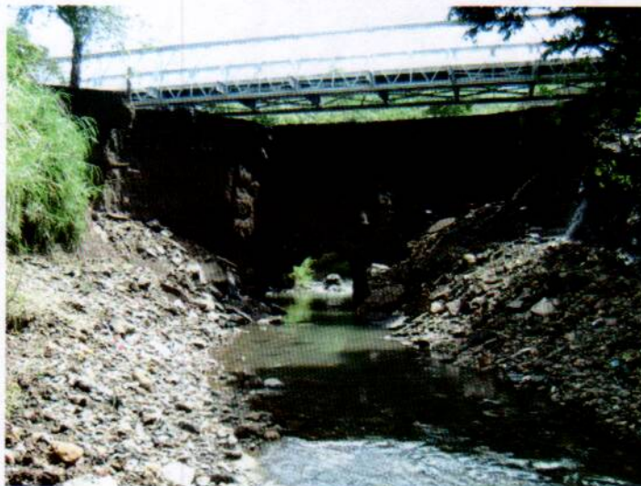
Figura 2. Vista lateral del paso sobre la quebrada Rivera.
