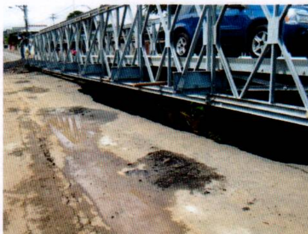
Figura 4. Colocación de un puente Bailey para restablecer el tránsito vehicular en ambos sentidos.
