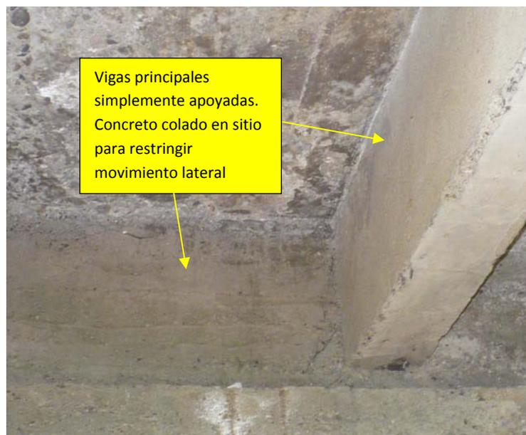
**Figura 5.** Vigas simplemente apoyadas sobre los bastiones las cuales cuentan con una viga secundaria para brindar estabilidad lateral.
