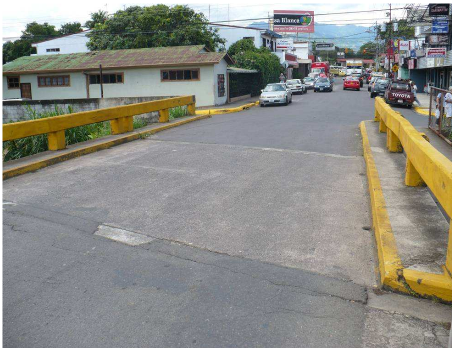
Figura 3. Vista frontal, hacia el Sur, del puente.
