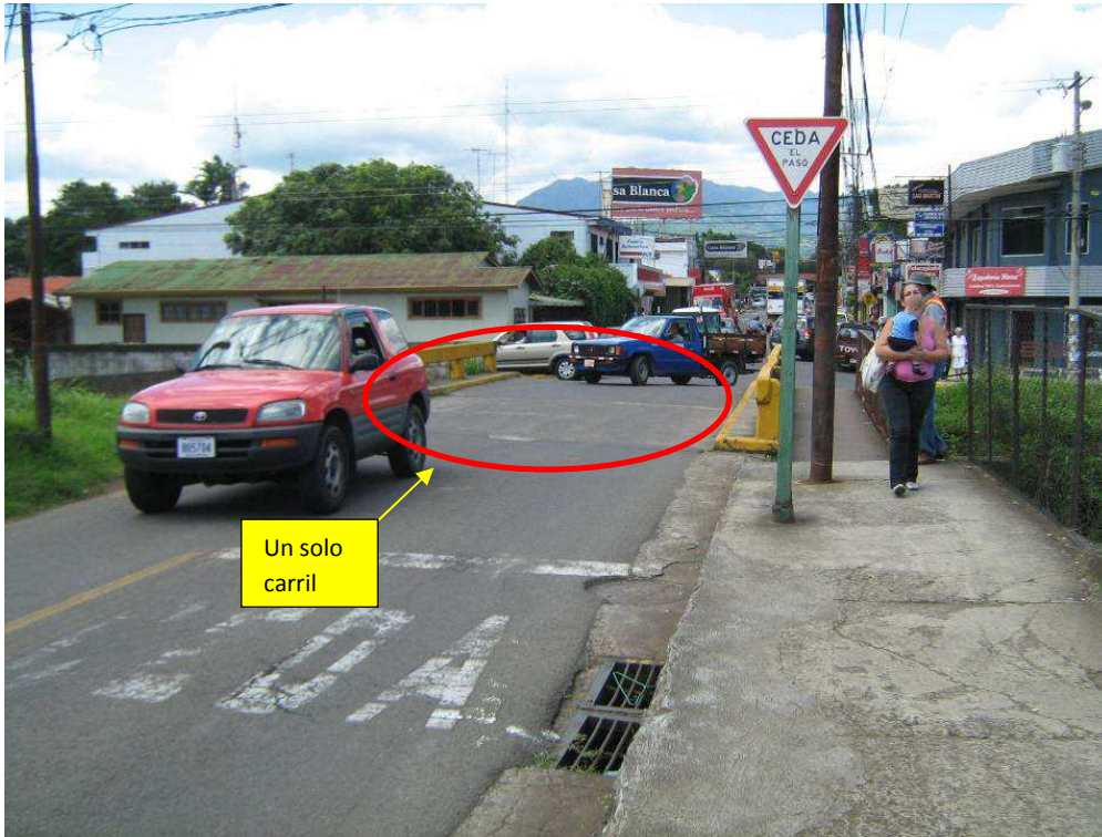
Figura 4. Puente de un sólo carril, señal de ceda.
