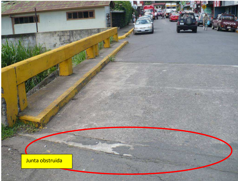
Figura 9. Juntas obstruidas.
