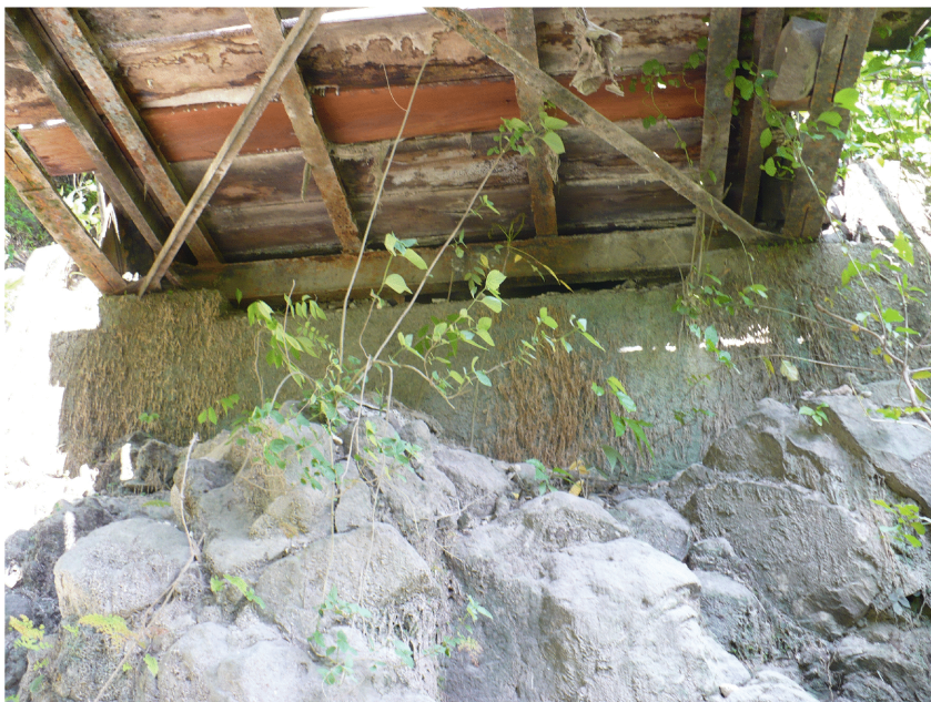
Foto No.1. Vista de apoyo tipo cabezal sobre rocas
