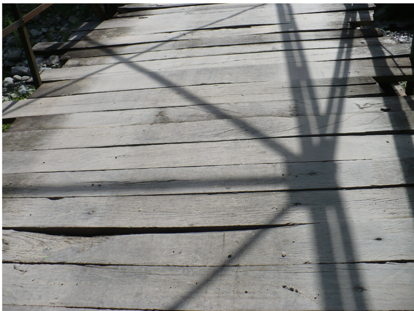
Foto No. 2. Vista de tablonces de piso de puente
