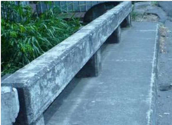
Figura 4. Barandas y aceras sin pintar, sin señalización, drenajes obstruidos (derecha).
