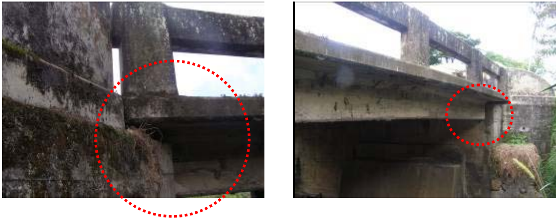
Figura 9. Apoyos de losa sobre bastiones.
