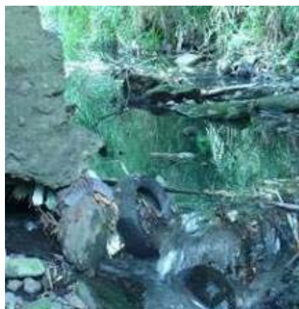
Figura 7. Acumulación de material de escombros y basura en el cauce.
