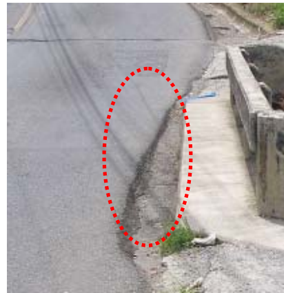
Figura 4. Barandas y aceras sin pintar, sin señalización, drenajes obstruidos (derecha).
