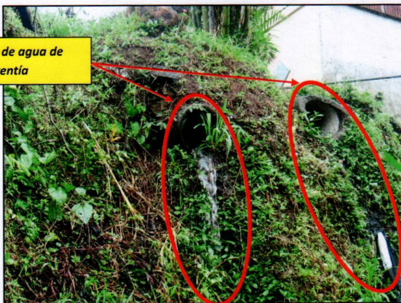
Fotografía 13. Agua de escorrentía mal canalizada descargada en taludes cercanos al puente. (Estado del puente al 19 de mayo de 2010).
