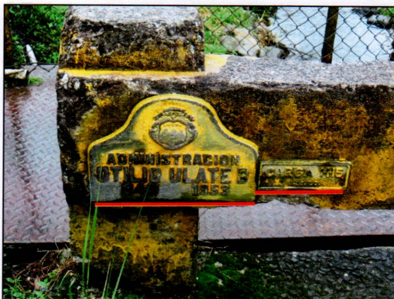
Fotografía 1. Placas indicando periodo de construcción y carga viva considerada para diseño. (Estado del puente al 19 de mayo de 2010).
