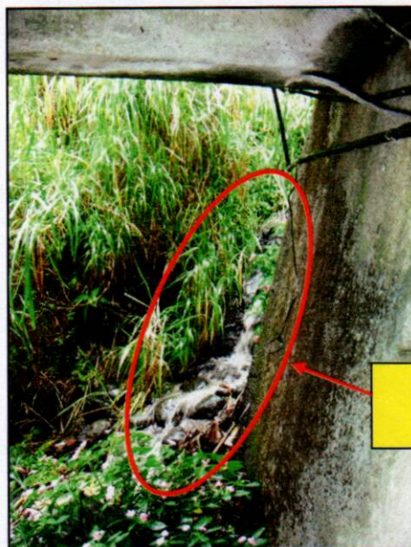
Fotografía 12. Agua de escorrentía sin canalizar. (Estado del puente al 19 de mayo de 2010).
