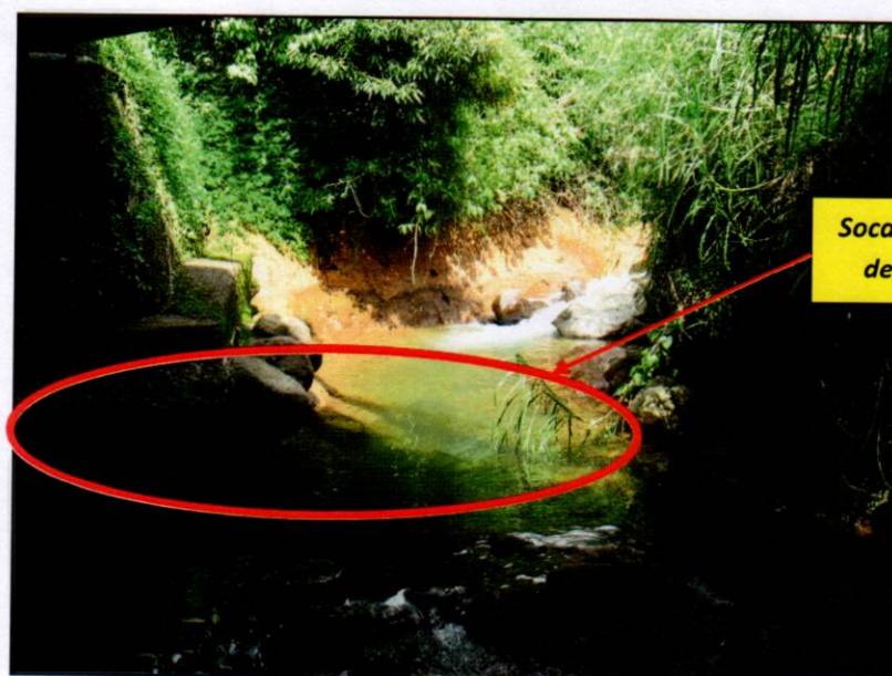
Fotografía 9. Socavación, aguas arriba, de cimentación de bastión (Estado del puente al 19 de agosto de 2010).
