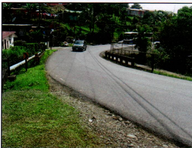
Fotografía 2. Vista general del puente sobre el Río Marín. (Estado de puente al 19 de agosto de 2010).
