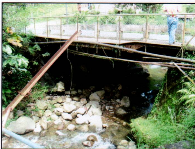
Fotografía 3. Vista lateral del puente (aguas abajo) sobre el Río Marín. (Estado de puente al 19 de agosto de 2010).
