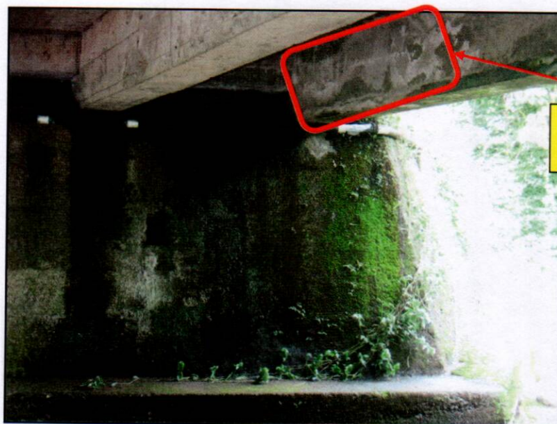
Fotografía 8. Zona con eflorescencia en vigas principales. (Estado del puente al 19 de agosto de 2010).
