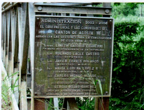
Figura 2. La placa indica el periodo de construcción.
