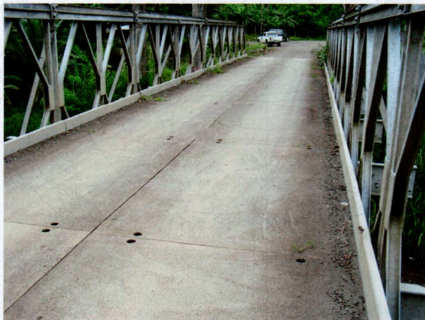
Figura 6. Acumulación de sedimento y presencia de vegetación por la falta de un sistema de drenajes y la falta de limpieza de la superficie de rodamiento.
