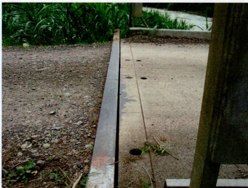
Figura 5. Vista de la junta de expansión sobre el Bastión-Sur
