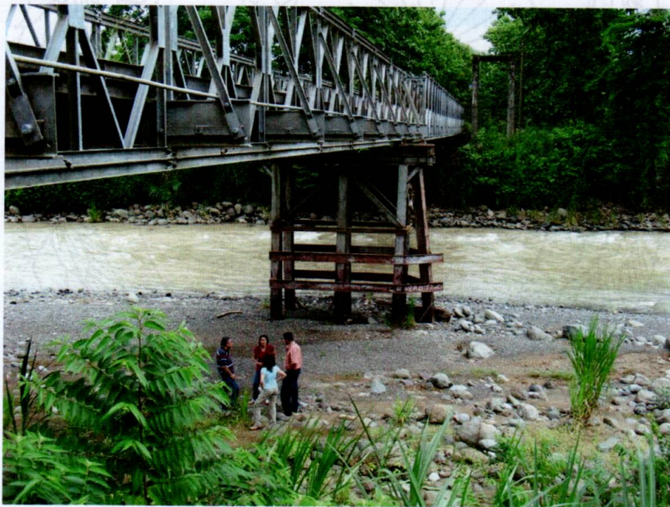
Figura 4. Vista lateral del puente mostrando los dos claros y las dos superestructuras
