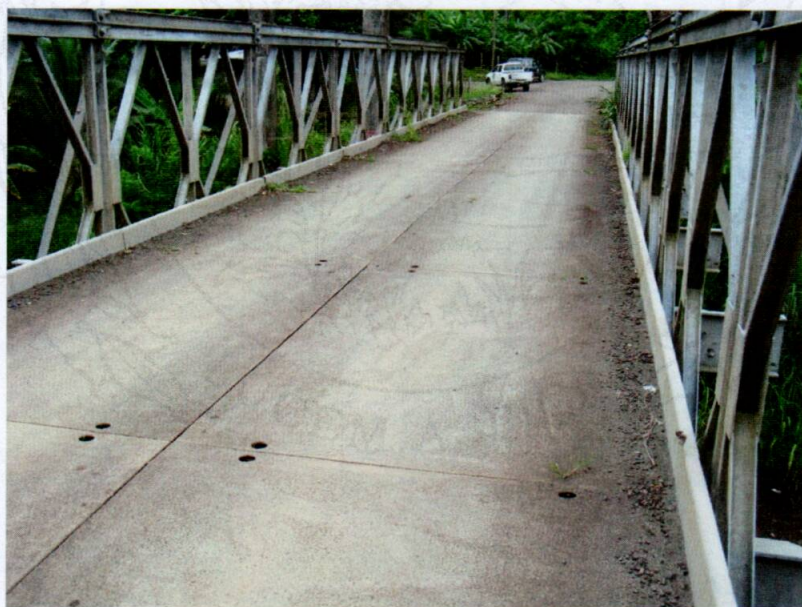
Figura 3. Vista general del puente mostrando la estructura modular tipo Bailey, la superficie de rodamiento y el ancho de la calzada.
