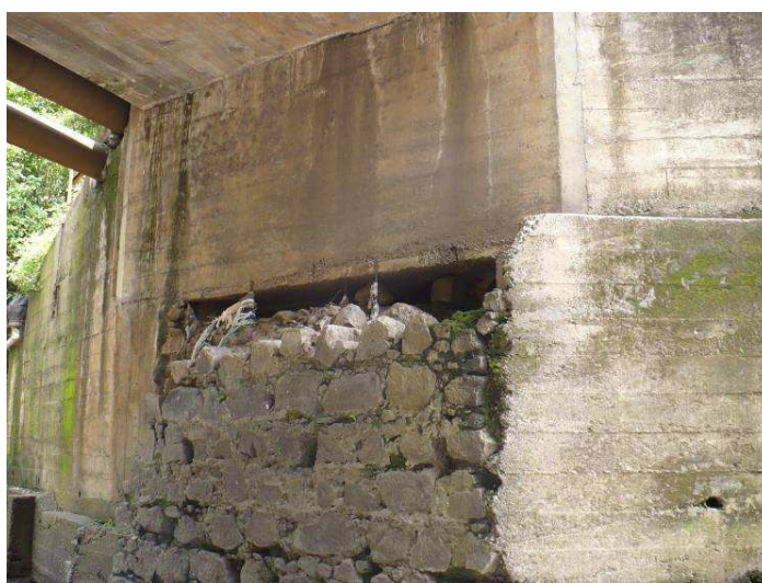
Figura 6. Bastión de concreto compuesto de un marco rígido el cual envuelve un muro de piedra.
