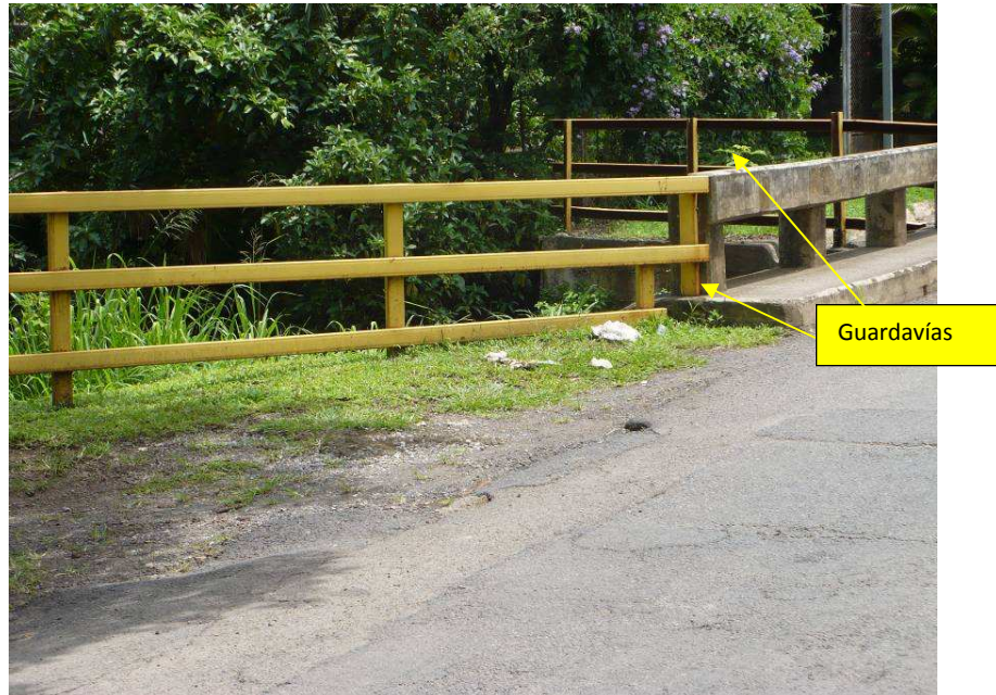
Figura 9. Sistema de guardavías, costado Oeste del puente.
