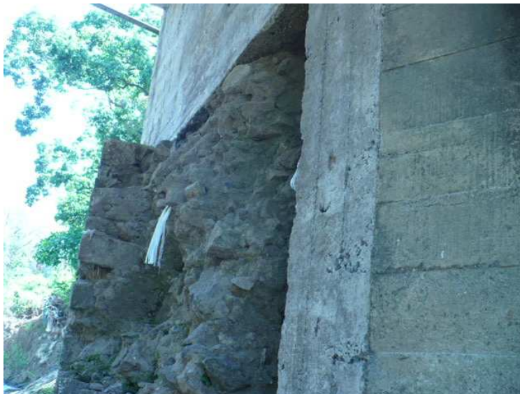
Figura 14. Bastión sur, talud de relleno al frente del bastión expuesto.
