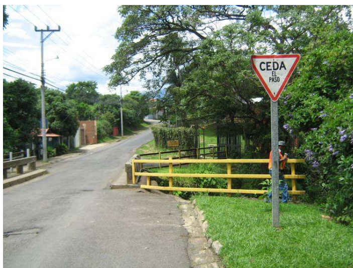
Figura 3. Vista frontal hacia el Sur, señalización tipo Ceda.
