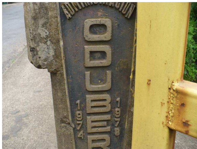
Figura 2. Placa con información del período de construcción del puente.
