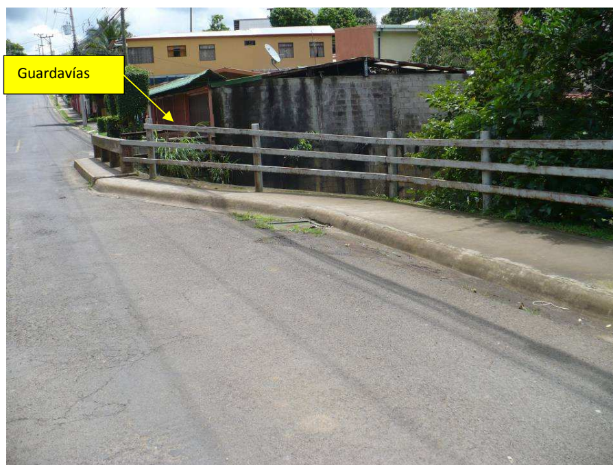
Figura 8. Sistema de guardavías, costado Este del puente.
