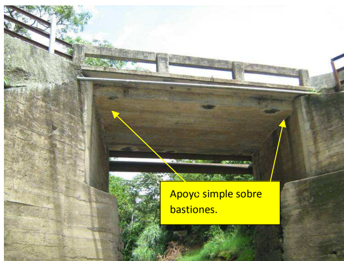
Figura 5. Vista lateral hacia Oeste, losa de concreto simplemente apoyada sobre los bastiones del puente.
