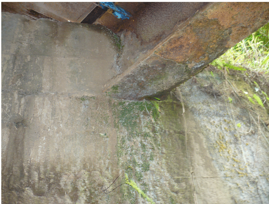
Figura 8. Apoyo típico de viga principal
