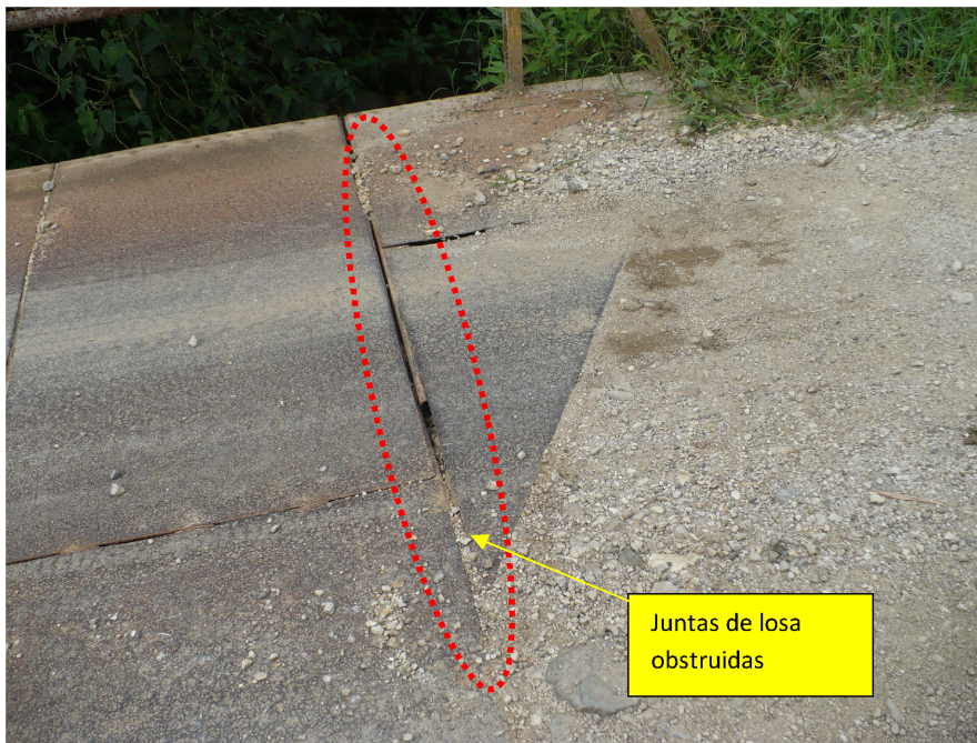
Figura 6. Juntas obstruidas.
