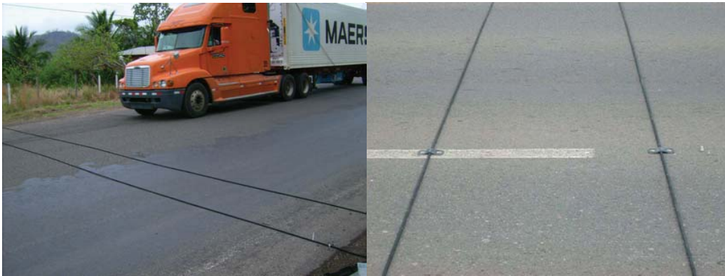
Figura 3. Cables y contadores automáticos en sitio. Fuente: LanammeUCR, 2008.
