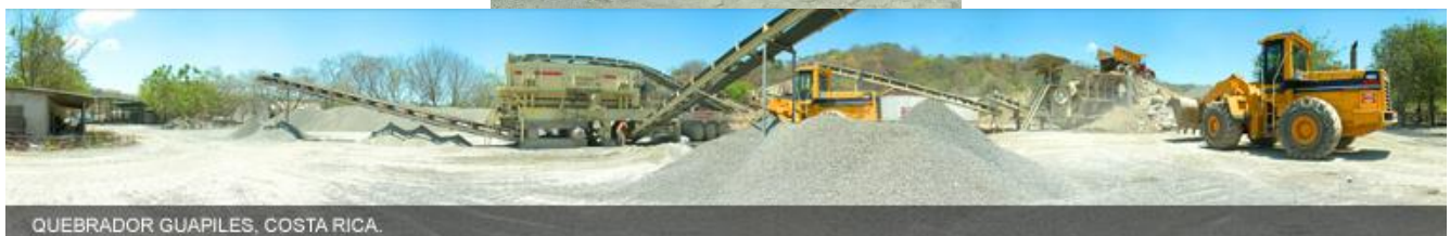
Figura 5: Extracción y producción del Agregado 1 .
