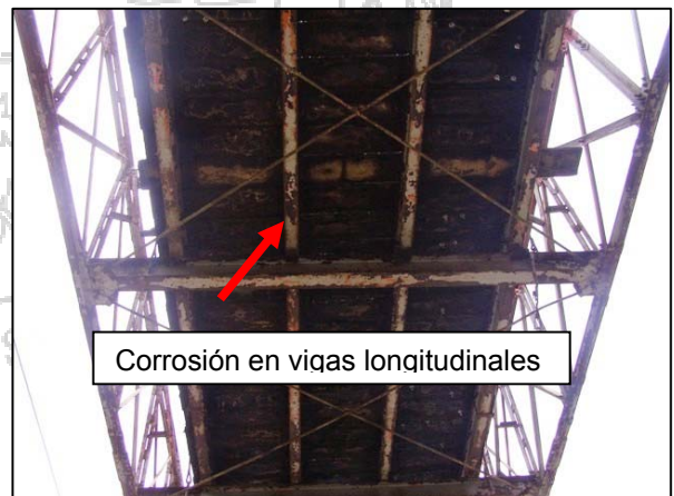
Fotografía No. 1 y No. 2. Elementos corroídos de la estructura del puente
