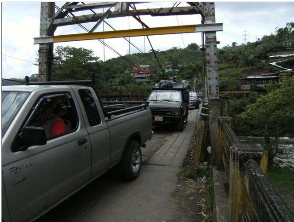
Fotografía No. 16. Circulación de vehículos de forma simultánea Fecha de fotografía 28-abr-2010) (Fuente: Unidad de Auditoría Técnica, LanammeUCR)
