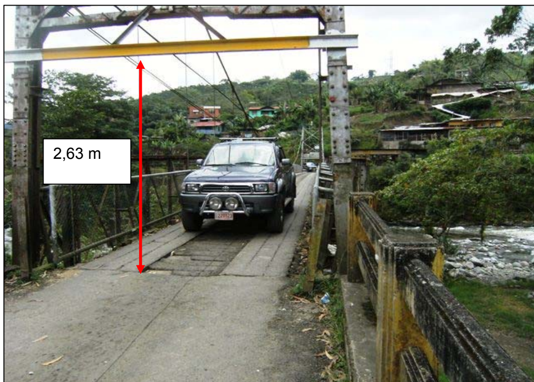
Fotografía No. 17. Altura de elementos de restricción de paso
