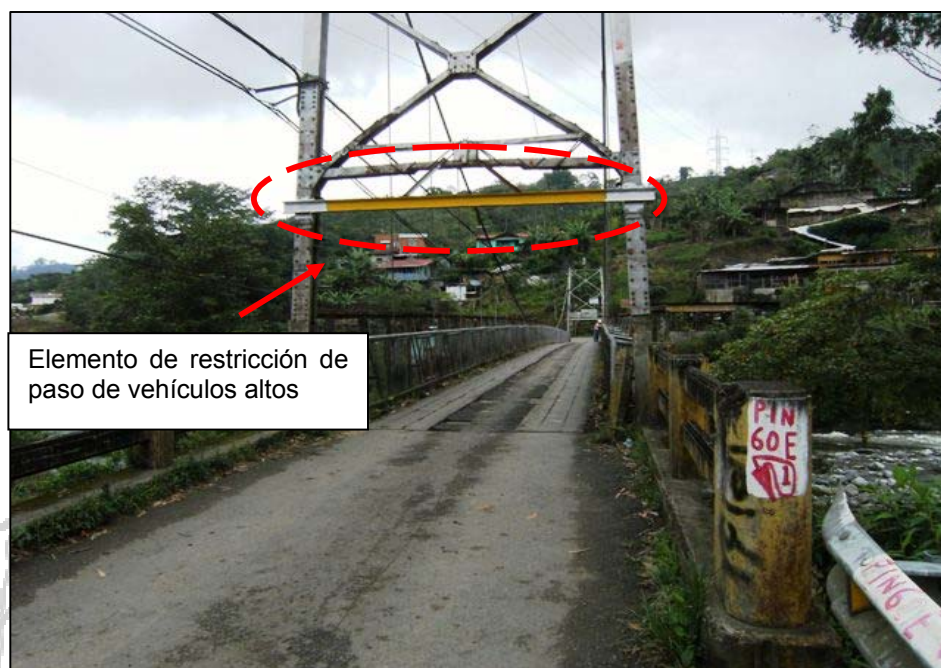
Fotografía No. 15. Elemento para restringir el paso de vehículos de cierta altura para limitar el peso (Fecha de fotografía 28-abr-2010) (Fuente: Unidad de Auditoría Técnica, LanammeUCR)
