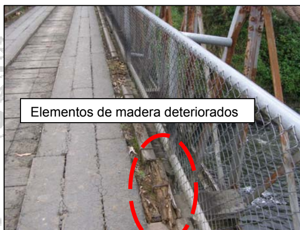
Fotografía No. 6 y No. 7. Baranda doblada y pieza de madera deterioradas (Fecha de fotografía 28-abr-2010) (Fuente: Unidad de Puentes, LanammeUCR)
