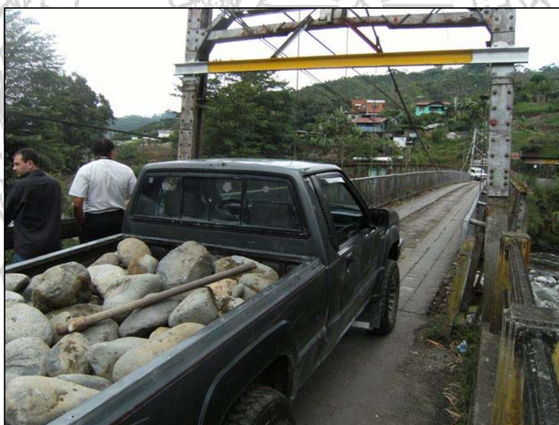
Fotografía No. 18 y No. 19. Vehículos cargados pasando sobre el puente Fecha de fotografía 28-abr-2010) (Fuente: Unidad de Auditoría Técnica, LanammeUCR)
