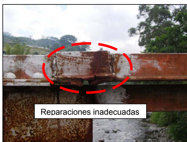
Fotografía No. 3 y No. 4. Reparaciones irregulares y golges en la viga de rigidez (Fecha de fotografía 28-abr-2010) (Fuente: Unidad de Puentes, LanammeUCR)
