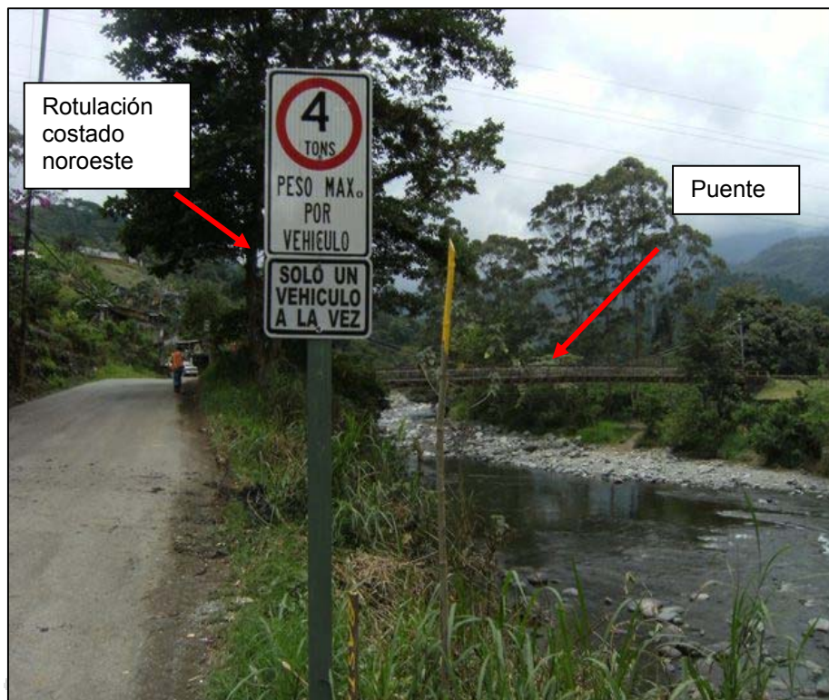
Fotografía No. 13. Rotulación lejana de la entrada del puente, costado noroeste (Fecha de fotografía 28-abr-2010) (Fuente: Unidad de Auditoría Técnica, LanammeUCR)
