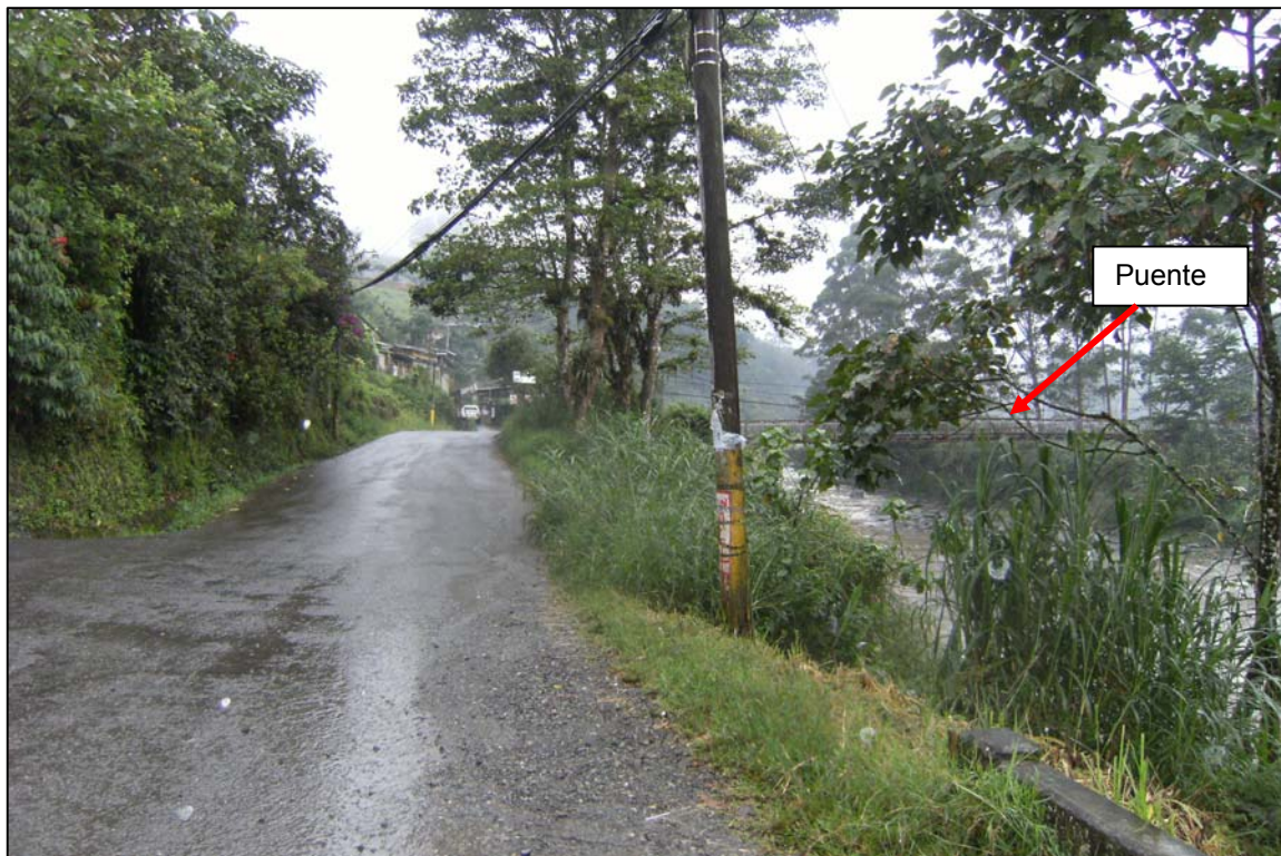
Fotografía No. 14. Rotulación inexistente en la entrada del puente, costado noroeste (Fecha de fotografía 01-dic-2010) (Fuente: Unidad de Auditoría Técnica, LanammeUCR)
