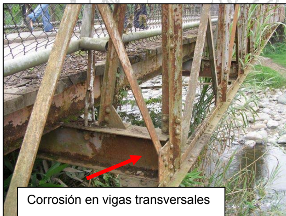
Fotografía No. 1 y No. 2. Elementos corroídos de la estructura del puente
