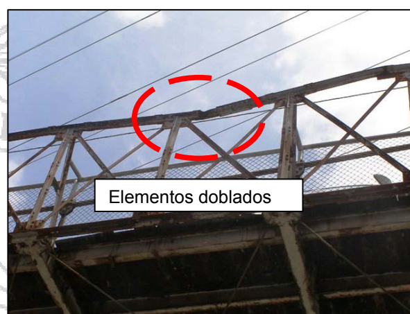
Fotografía No. 3 y No. 4. Reparaciones irregulares y golges en la viga de rigidez (Fecha de fotografía 28-abr-2010) (Fuente: Unidad de Puentes, LanammeUCR)
