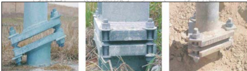
Fotografías N° 4, N° 5 y N° 6. Ejemplos de postes colapsables.
