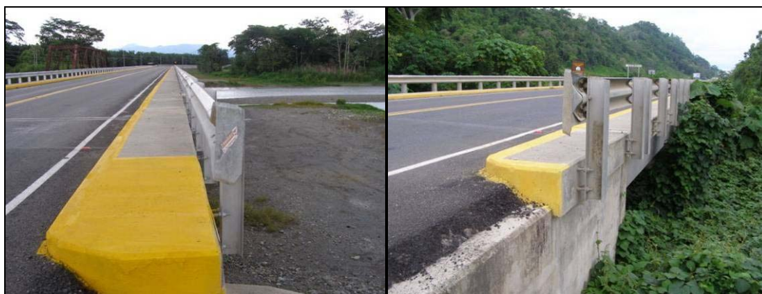
Fotografías N° 21 y N° 22. Uso de barreras de seguridad en los puentes (Mayo, 2010).
