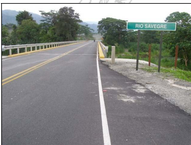
Fotografías N° 21 y N° 22. Uso de barreras de seguridad en los puentes (Mayo, 2010).
