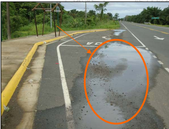
Fotografías N° 31 y N° 32. Presencia de agua en la superficie de ruedo (Agosto, 2010).
