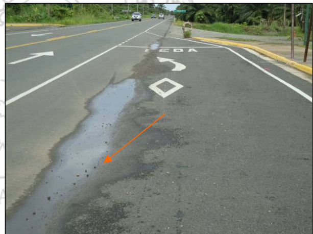
Fotografías N° 31 y N° 32. Presencia de agua en la superficie de ruedo (Agosto, 2010).
