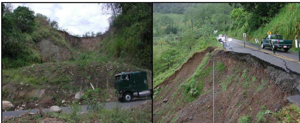
Figura 36: Fotografías de deslizamientos y fallas de taludes típicos presentes en la ruta 10
