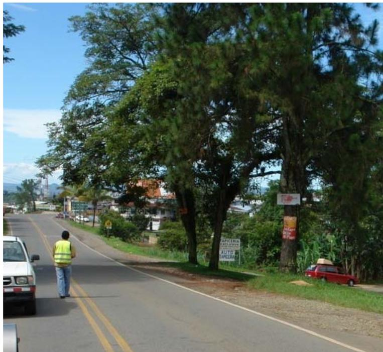
Figura 27: Existencia de árboles robustos dentro del derecho de vía; ruta 2, sección 10010, estación 0+800
