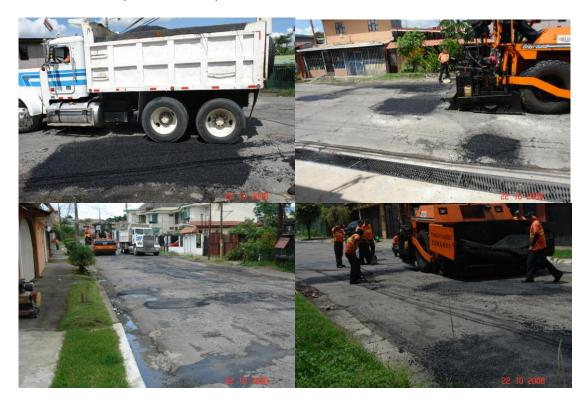
Se aprecia la mala condición estructural del pavimento, también se observa que los baches no fueron saneados ni cortados con sierra. Se nota también que los drenajes no fueron arreglados y la mala condición de la carpeta asfáltica.
