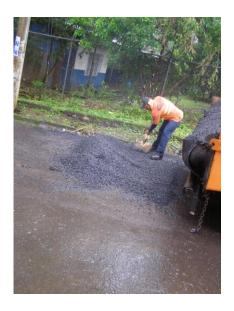
En ésta figura se aprecia como la mezcla se tiró accidentalmente en el pavimento, y la misma fue recogida con pala y se volvió a mezclar con el resto, disminuyendo aún más su temperatura además de contaminarla.
