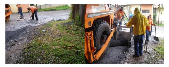
Se aprecia que la mezcla se esparce sobre el área de trabajo con pala, promoviendo la segregación del material. Además se tira el material sobrante al lado de la calle. También se aprecia la falta de drenajes adecuados y el trabajo realizado en condición húmeda y de lluvia.
