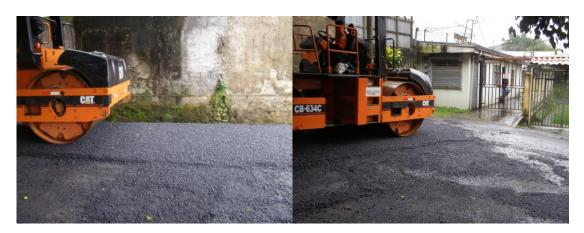
Se puede apreciar en estas dos figuras que la superficie de trabajo y la mezcla estaban mojadas cuando se realizaba la compactación.
