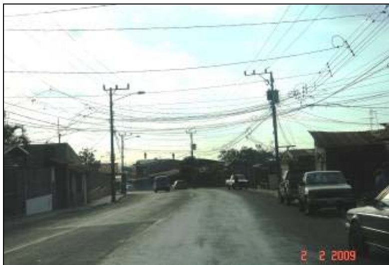
Fotografía No. 5: Exudación de asfalto. Las fotografías ejemplos de sitios donde se observa exudación de asfalto. Estación 1+700 Ruta Nacional No. 102, el día 28 de octubre del año 2008.
