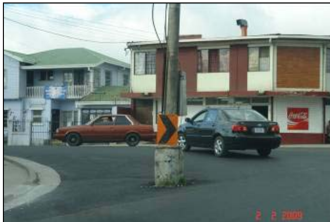
Fotografía No. 2: Postes en la vía. Este es otro ejemplo de un obstáculo en la vía corresponde al estacionamiento 1+000 aprox. de la Ruta Nacional No. 102 donde a la fecha de la visita aún permanece un poste. La fotografía fue tomada el 02 de febrero del 2009.
