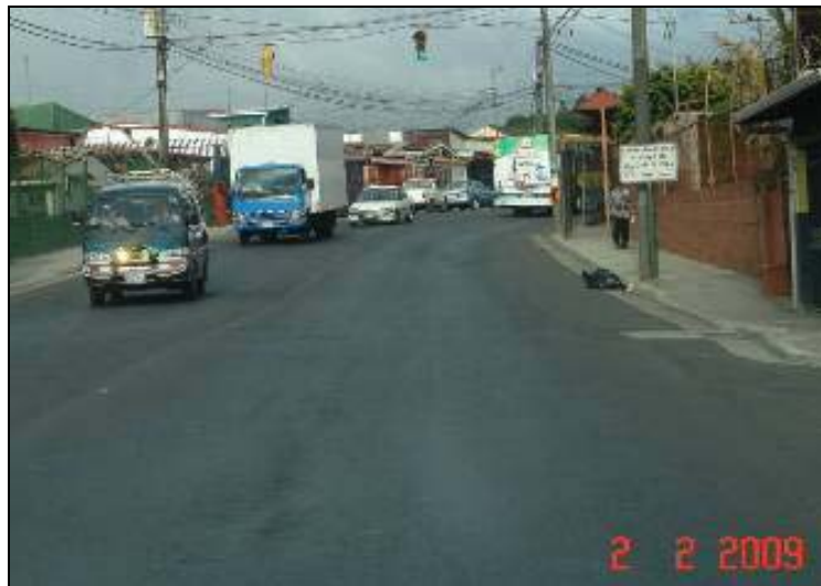
Fotografía No. 4: Exudación de asfalto. Las fotografías ejemplos de sitios donde se observa exudación de asfalto. Estación 1+700, Ruta Nacional No. 102, el día 28 de octubre del año 2008.
