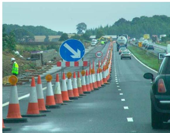
**Fotografía No. 10.** Canalización vehicular por medio de conos a través de una zona de trabajo (<http://www.freefoto.com>).
