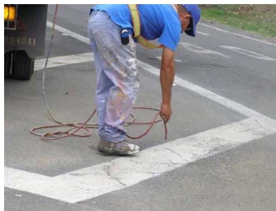
Fotografía 12. Limpieza de la calzada por medio de un soplador de aire.
