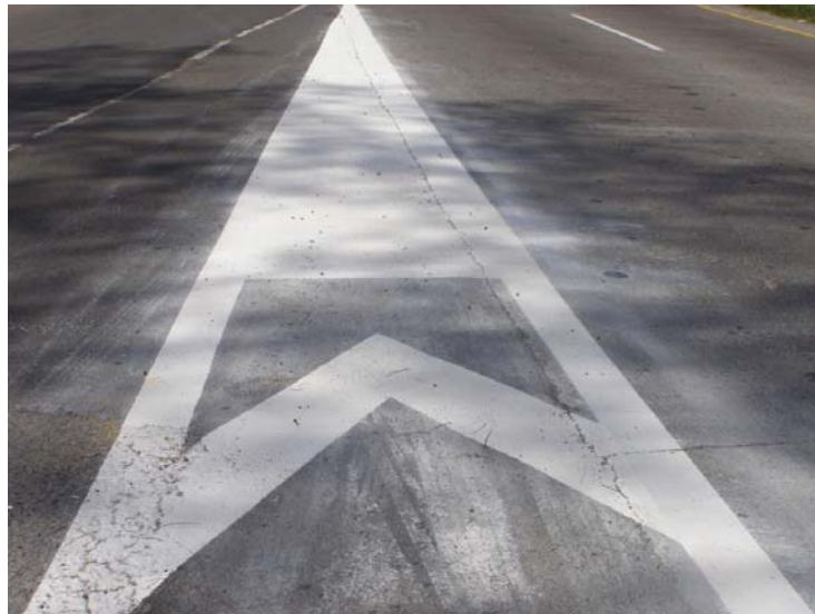
Fotografía 4. Efecto de la lluvia en la pintura, sin haber completado su etapa de secado. (Fecha: 29 de abril del 2008)
