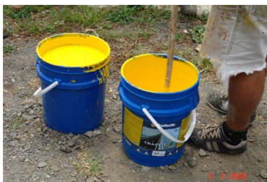
Fotografía 2. Mezclado de la pintura disuelta en agua. (Fecha: 3 de abril del 2008)
