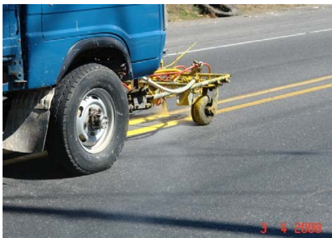
Fotografía 5. Equipo de colocación de pintura a presión con aire (Conventional Air Spray). (Fecha: 3 de abril del 2008)
