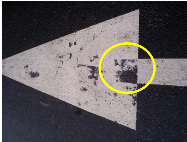
Fotografía 3. Flecha de prueba donde se observan fallas prematuras de adherencia de la pintura. (Fecha: 10 de abril del 2008)
