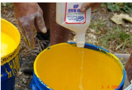
Fotografía 1. Dilución de la pintura con agua. (Fecha: 3 de abril del 2008)
