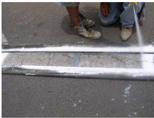
Fotografía 8. Sección de prueba para ajustar la presión del equipo y dar el espesor adecuado. (18 de abril del 2008)
