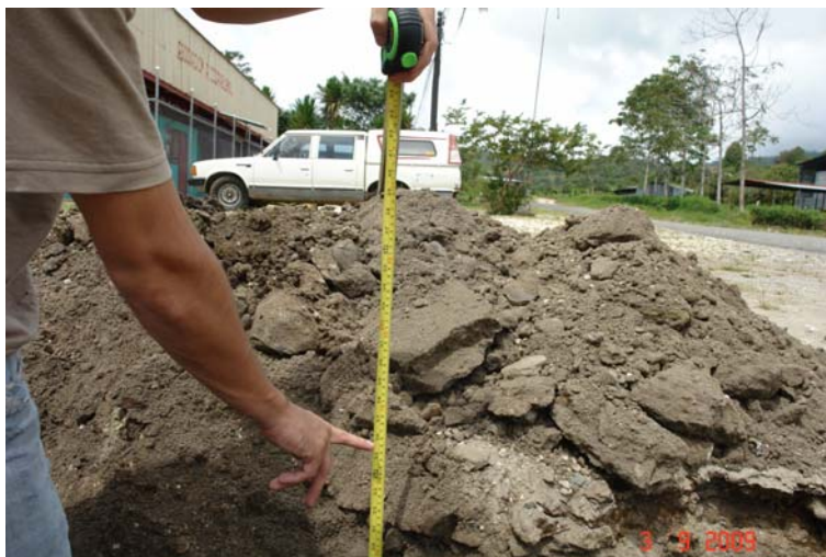
Figura 13: Exploración de la estructura 4 (0+850), proyecto Copa Buena A.
