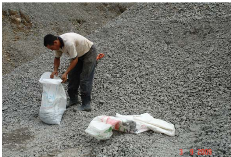
Figura 19: Muestreo del material para la base estabilizada.
