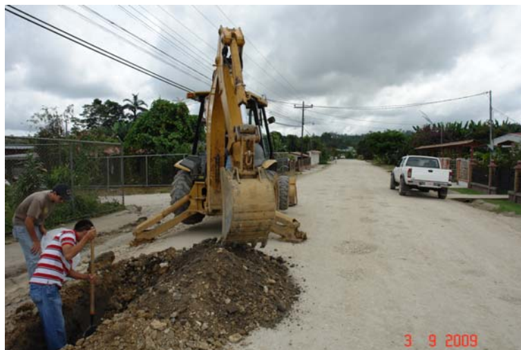
Figura 8: Exploración de la estructura 2 (0+400), proyecto Copa Buena A.
