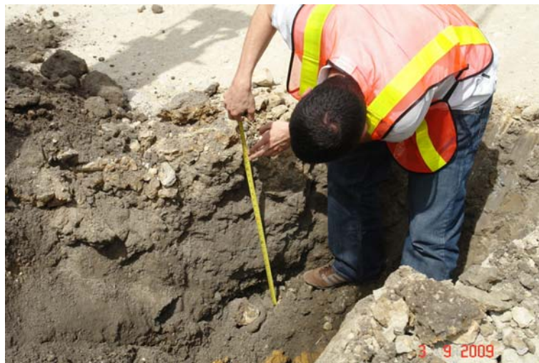
Figura 7: Exploración de la estructura 1 (0+200), proyecto Copa Buena A.
