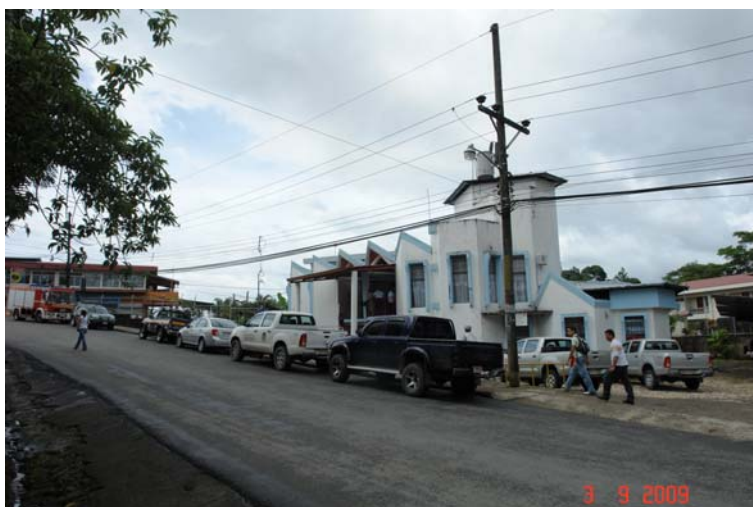
Figura 22: Edificio Municipal de la Municipalidad de Coto Brus.
