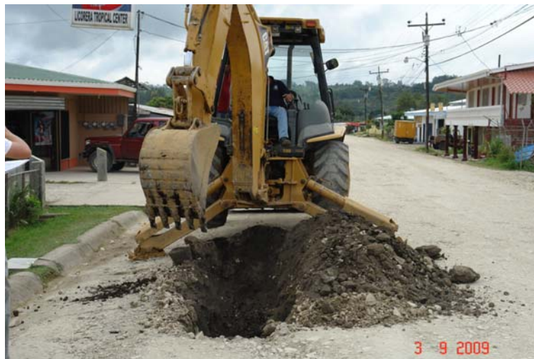
Figura 10: Exploración de la estructura 3 (0+600), proyecto Copa Buena A.
