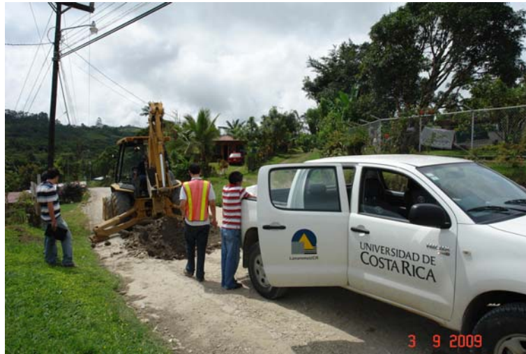
Figura 6: Exploración de la estructura 1 (0+200), proyecto Copa Buena A.
