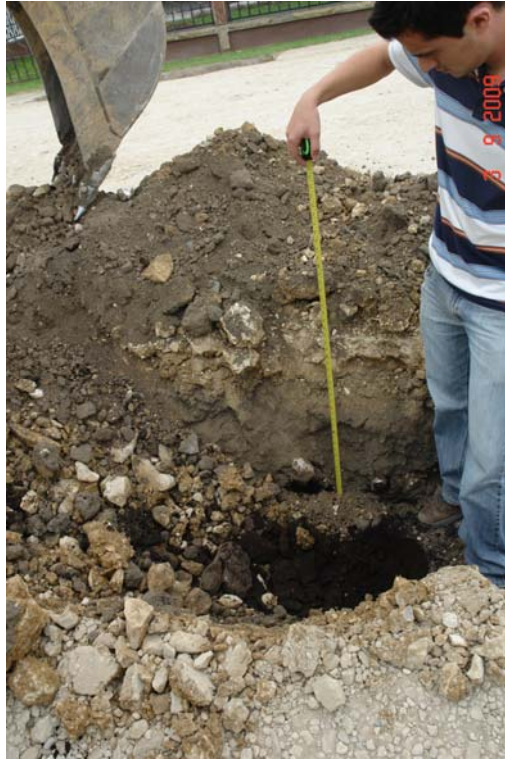
Figura 9: Exploración de la estructura 2 (0+400), proyecto Copa Buena A.
