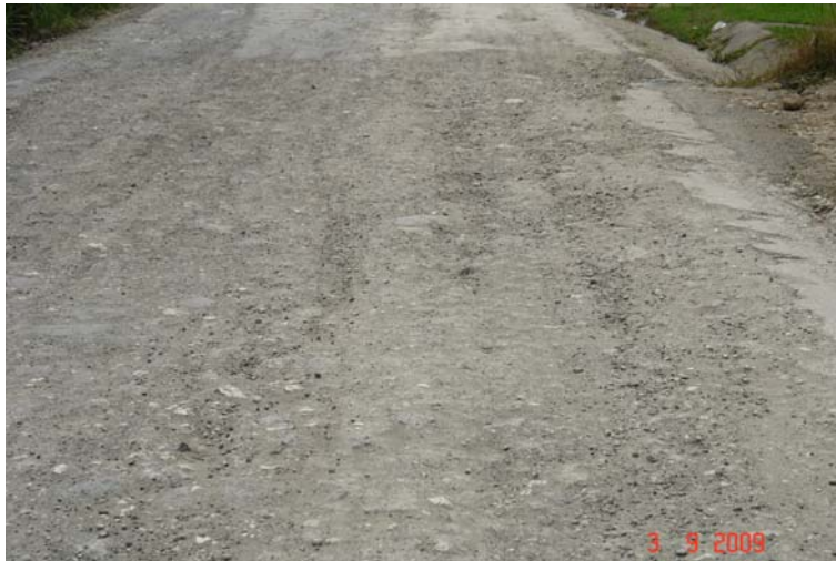
Figura 15: Restos de base estabilizada existente junto con el "lastre" colocado, proyecto Copa Buena A.
