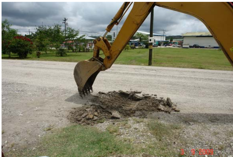
Figura 12: Exploración de la estructura 4 (0+850), proyecto Copa Buena A.
