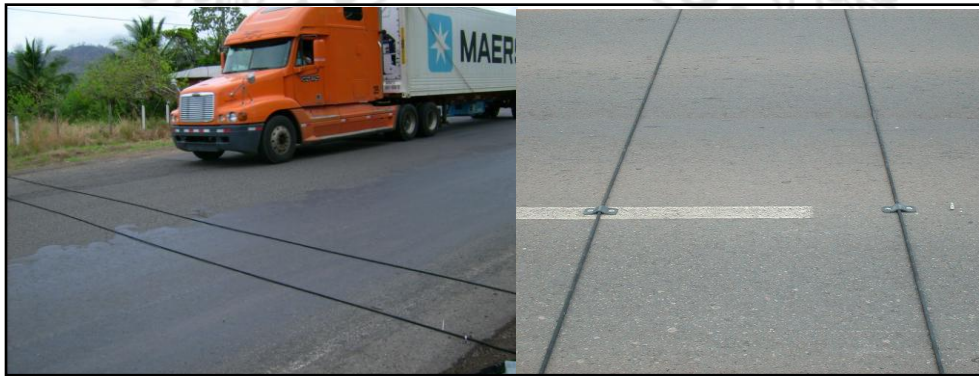
Figura 5. Cables y contadores automáticos en sitio. Fuente: LanammeUCR, 2008.
