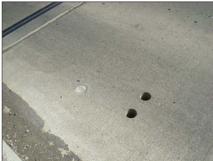
Figura 2.7: Vista de la losa reparada
