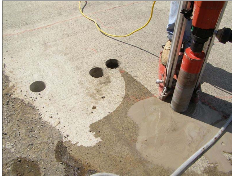
Figura 2.1: Extracción de núcleo de la losa (sección 11).
