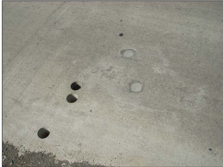
Figura 2.6: Vista de la losa reparada
