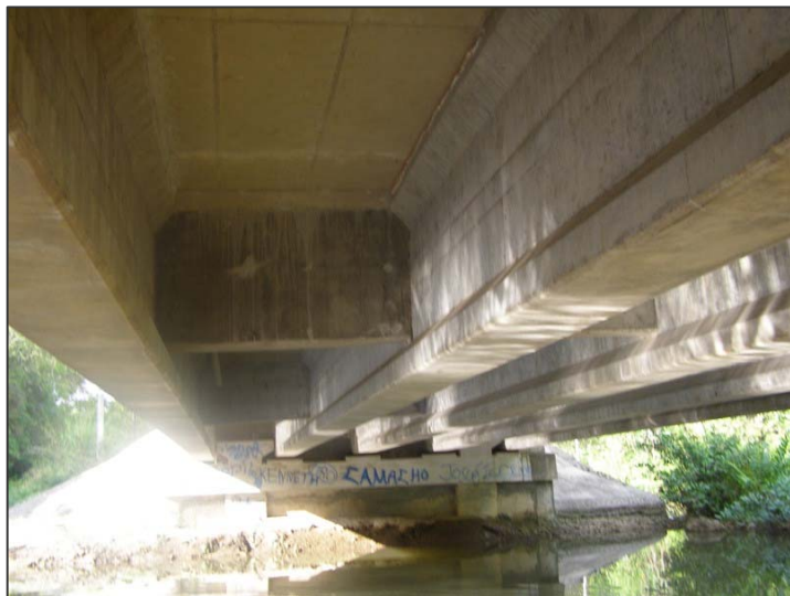
Figura 3.4: Puente sobre Estero La Bomba
