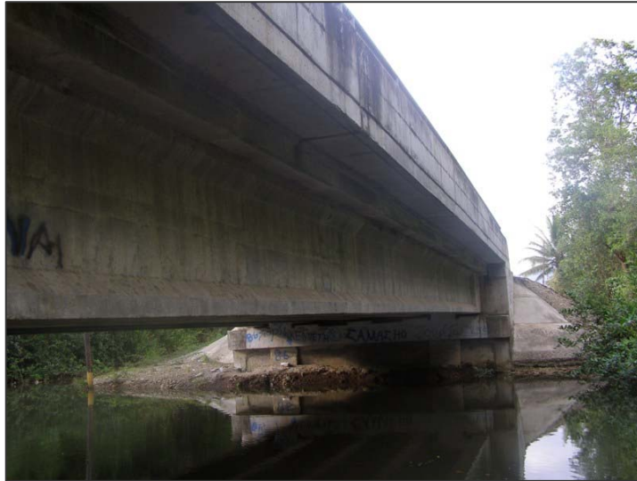
Figura 3.3: Vista lateral del puente sobre Estero La Bomba
