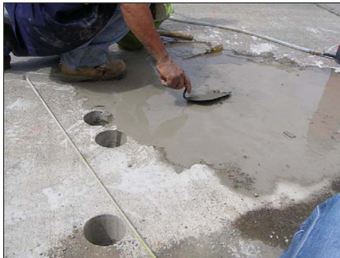
Figura 2.5: Reparación de la losa
