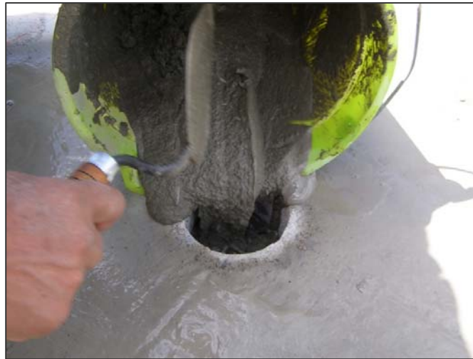
Figura 2.4: Reparación de la losa
