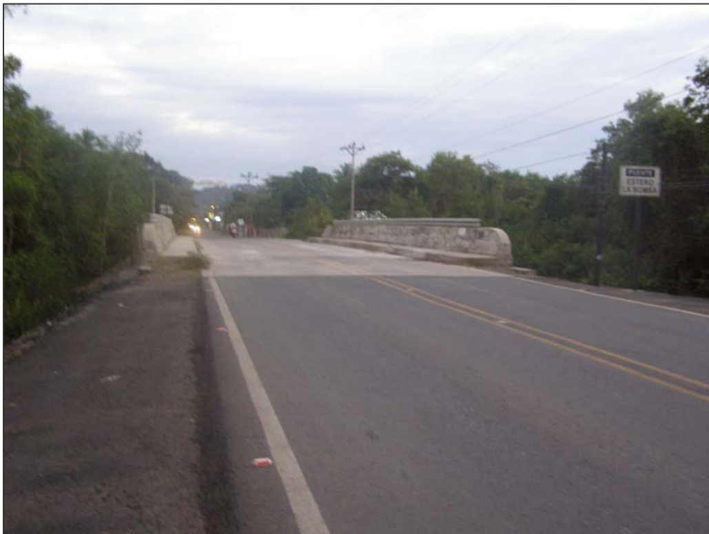
Figura 3.2: Puente sobre Estero La Bomba
