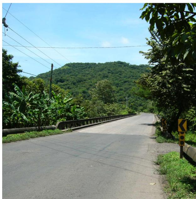
La estructura del puente se considera simplemente apoyada en la dirección longitudinal con columnas en voladizo en la dirección transversal, además no cuenta con sesgo alguno. En el costado norte del puente existe una elevación de la rasante, por lo cual el alineamiento vertical presenta una pendiente, sin embargo el alineamiento horizontal es recto.
