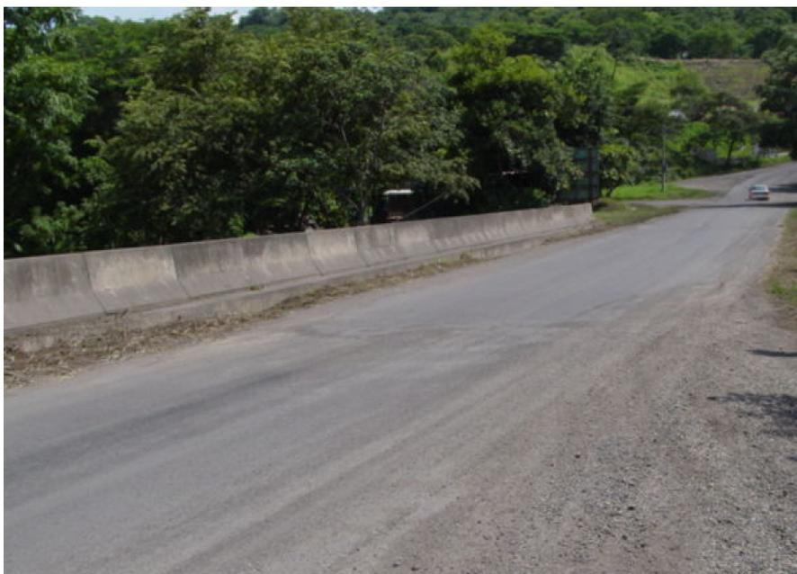
La estructura del puente se considera simplemente apoyada en la dirección longitudinal, aún cuando la pila central no permita desplazamientos, con columnas en voladizo en la dirección transversal, además cuenta con un sesgo aproximado de 20°.
