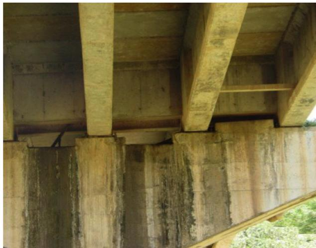
En cuanto a las fundaciones de las pilas se suponen que son placas superficiales rectangulares y se encuentran unidas de manera integral con las columnas de las pilas y de los bastiones. Cabe resaltar que no existe un estudio de suelos del sitio, por lo cual no se conoce la capacidad soportante del suelo.
