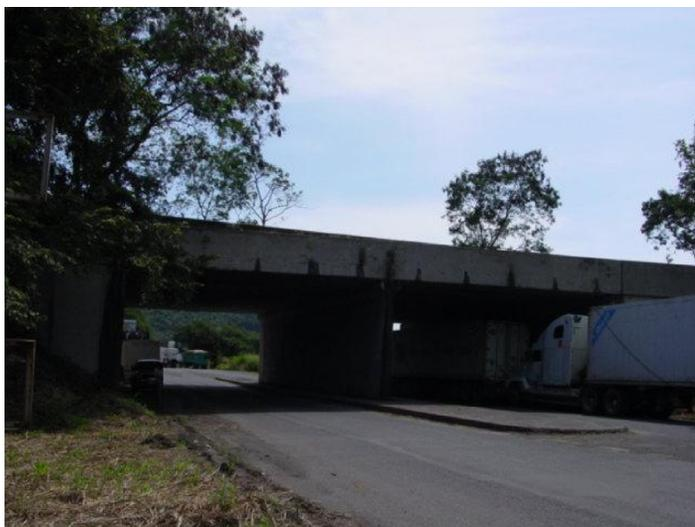
El puente posee un ancho de calzada de 23 metros, lo cual permite tránsito en dos carriles, adicionalmente permite la existencia de espaldones a los extremos y se dispone de barandas perimetrales tipo New Jersey.
