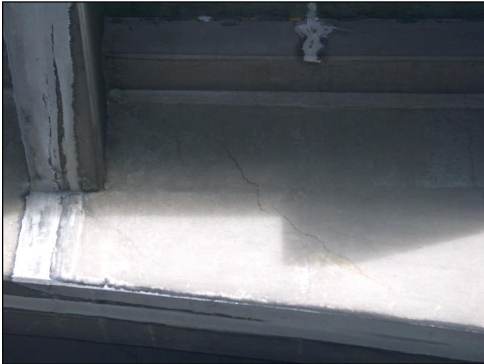
Figura 19: Manchas por filtración de agua
