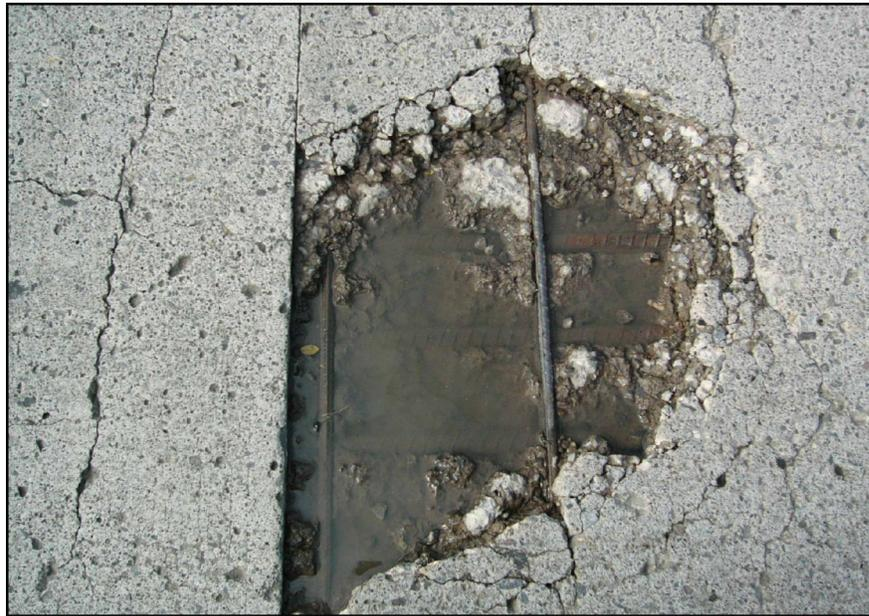
Figura 53: Acero expuesto cubierto con asfalto
