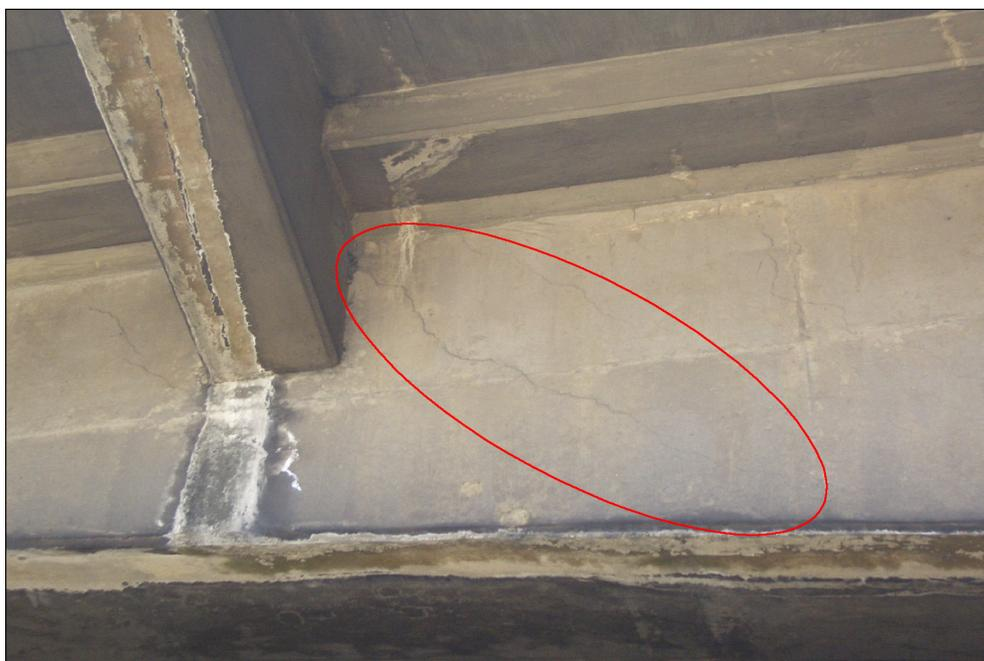
Figura 18: Fisuras por flexión y por cortante en las vigas
