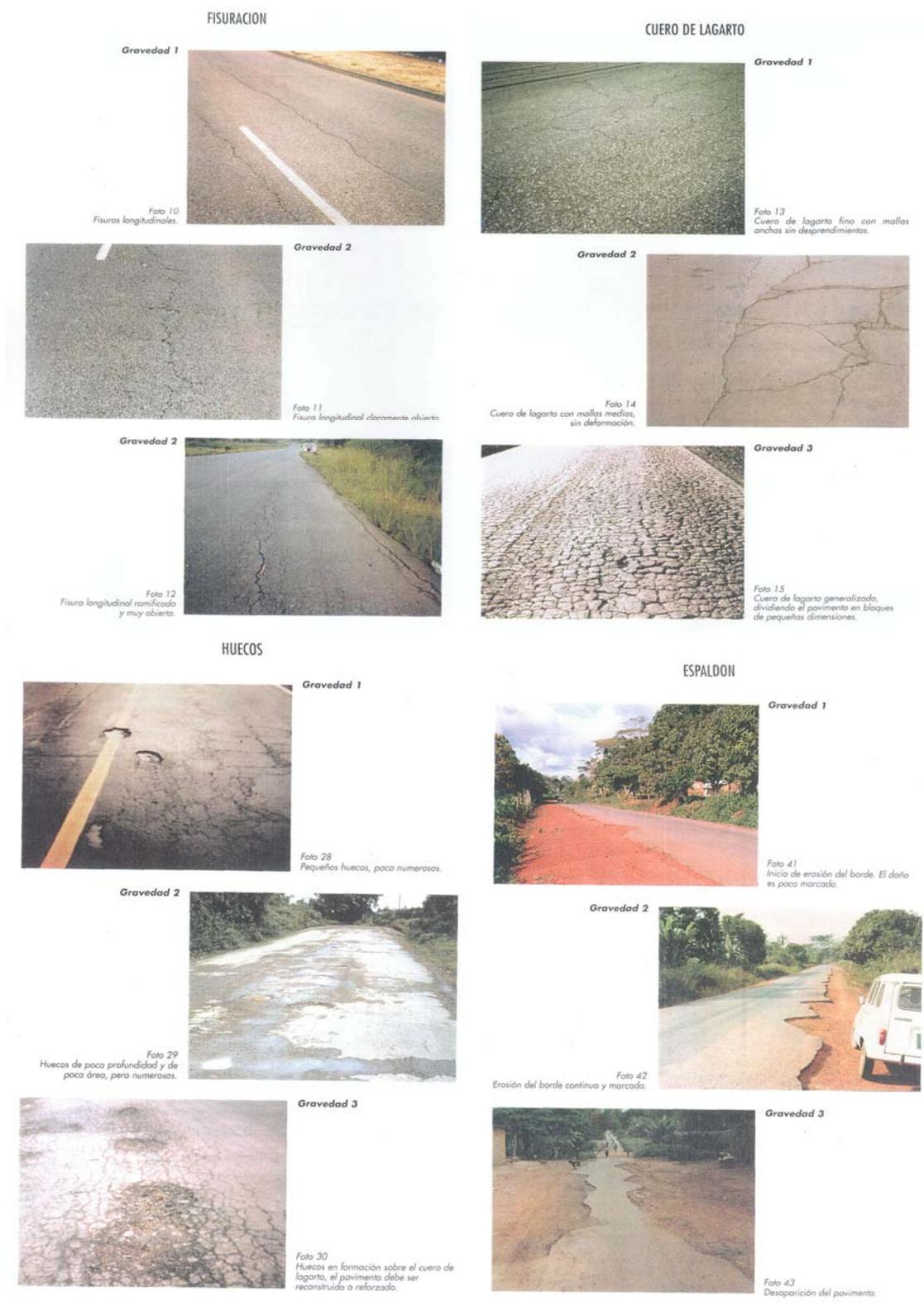
Figura 10. Ejemplos de daños superficiales con metodología VIZIR (Fuente: VIZIR, técnicas y métodos).
