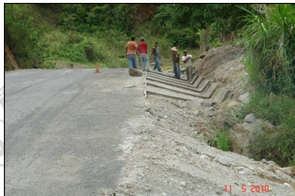
Fotografía N°35. Trabajos en cunetas. Estacionamiento 23+892. (Fecha 11/05/10)
