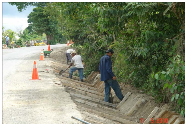
Fotografía N°34. Trabajos en cunetas. Estacionamiento 15+700. (Fecha 11/05/10)
