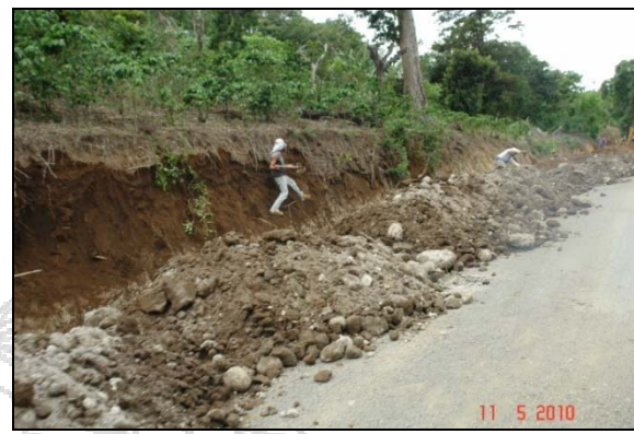
Fotografía N° 36 y N°37. Trabajo de colocación de alcantarilla por parte de AyA. Estacionamiento 24+600 al 30+000 (Fecha 11/05/10)
