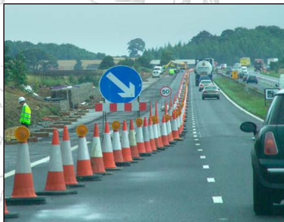
Fotografía N°29. Canalización vehicular por medio de conos a través de una zona de trabajo ( http://www.freefoto.com ).
