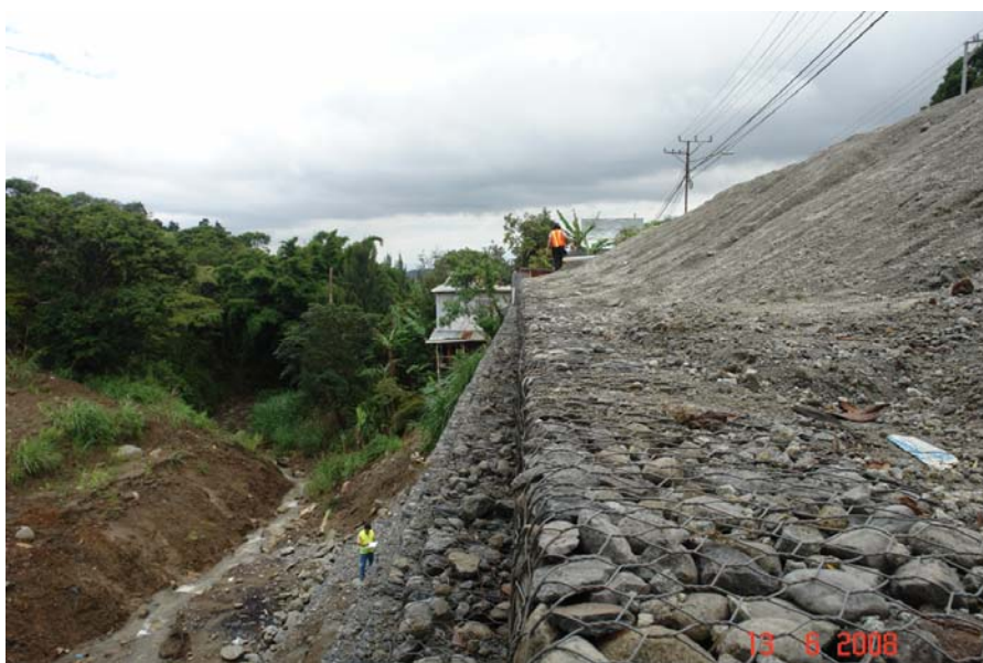
Fotografía No. 1: Vista general del muro de gaviones de la “Cuesta del Fierro”. Ruta Nacional No. 2. Fecha 13 de junio de 2008.
