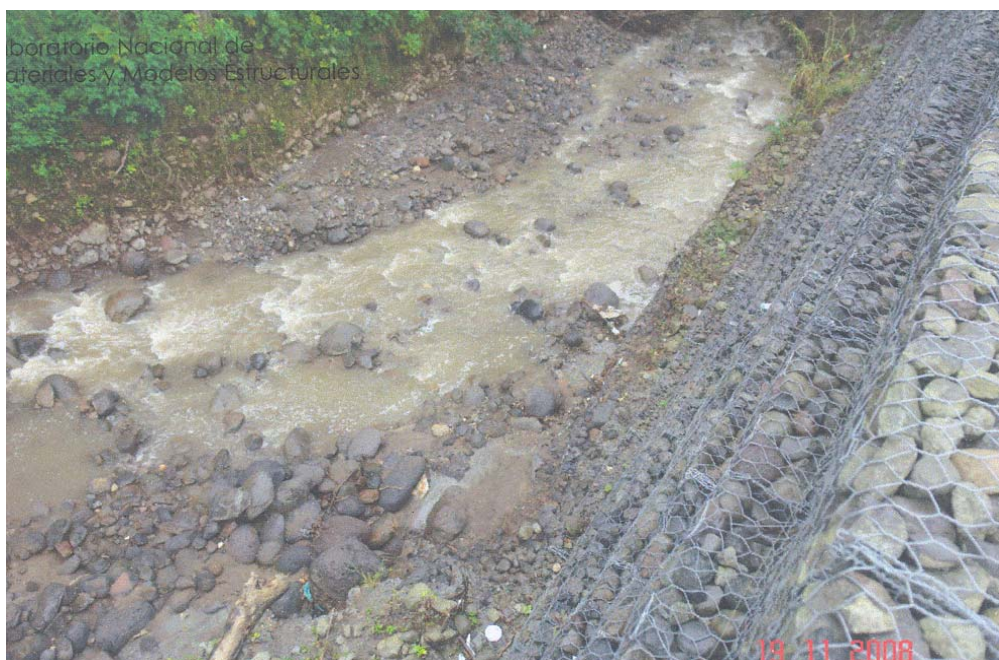
Fotografía No. 5: Vista general del muro de gaviones de Ochomogo, nótese la forma del cause del río y su cercanía con el muro. Ruta Nacional No. 2. Fecha 13 de junio de 2008
