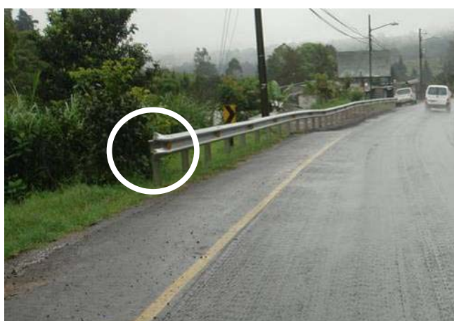
Fotografía No. 8: Sistemas de contención lateral instalados con terminal tipo “cola de pez” en sentido de la circulación del tránsito. Ruta Nacional No. 2. Fecha 10 de octubre del 2008
