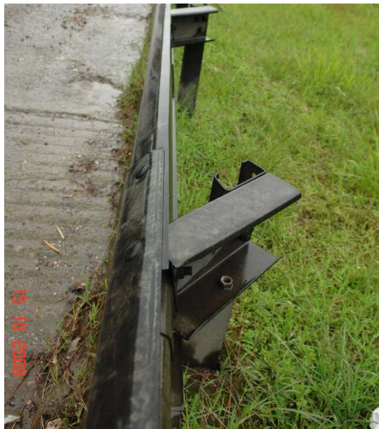
Fotografía No. 9: Sistemas de contención lateral instalados con terminal tipo “cola de pez” en sentido de la circulación del tránsito. Ruta Nacional No. 2. Fecha 10 de octubre del 2008
