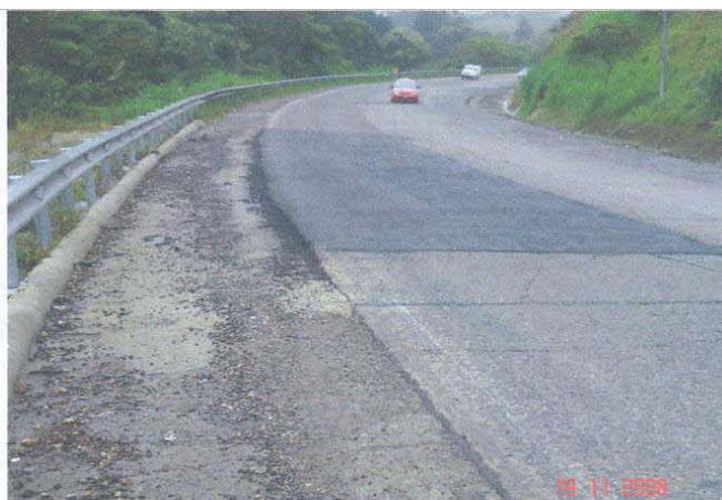
Fotografía No. 3 y 4: Losas agrietadas adyacentes al muro, Ochomogo Ruta Nacional No. 2. Fecha 15 de octubre de 2008 y 19 de noviembre de 2008 respectivamente.
