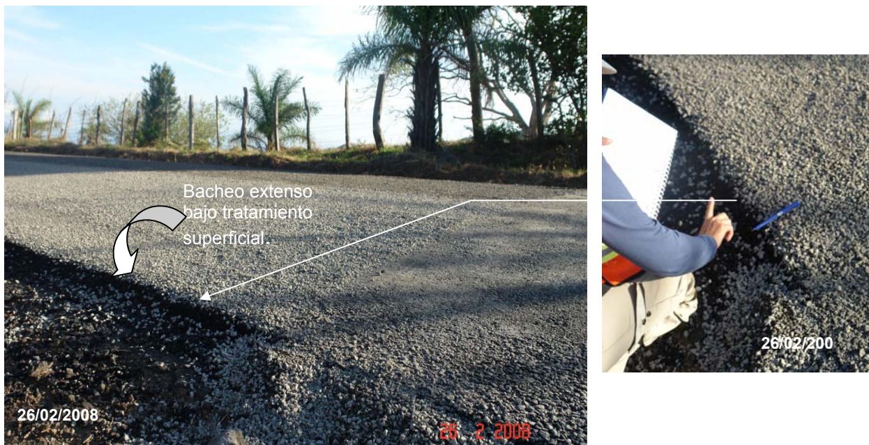
Fotografías No. 14,15 Colocación del tratamiento superficial sobre una capa de concreto asfáltico de nivelación de espesor variable.
