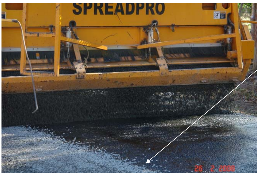
Fotografías 20 y 21. Abajo extensión de la quintilla. Al lado detalle de la junta entre el carril con agregado y el carril donde se aplica la emulsión.
