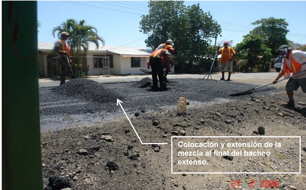
Fotografía 41. Colocación y extensión manual de la mezcla asfáltica en zona extensa de bacheo. Obsérvese la conformación de la primera capa de menos de 1,5 cm compactos.
