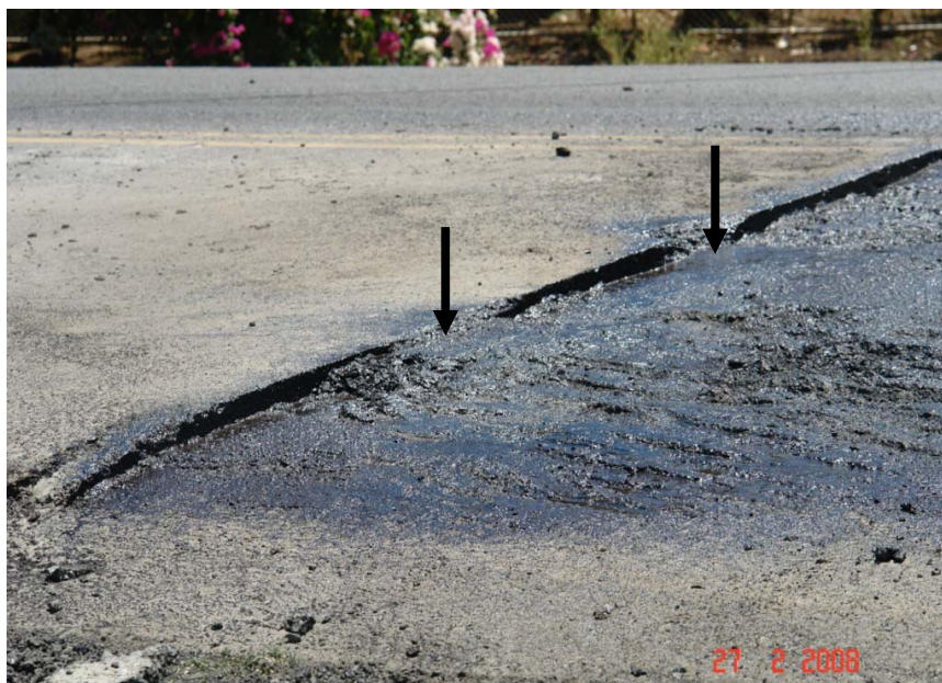
Fotografía 32. Aspecto general del borde de la zona de corte posterior al riego de liga.
