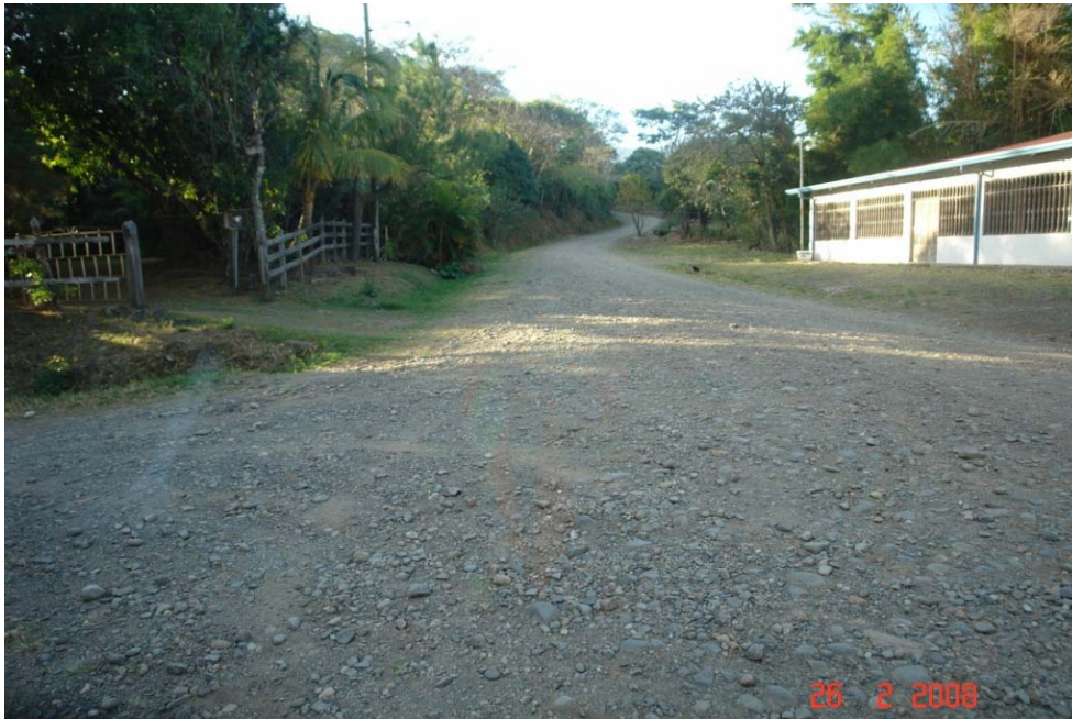
Fotografía 18. Cerrillos. La superficie de rodadura corresponde a un lastre.
