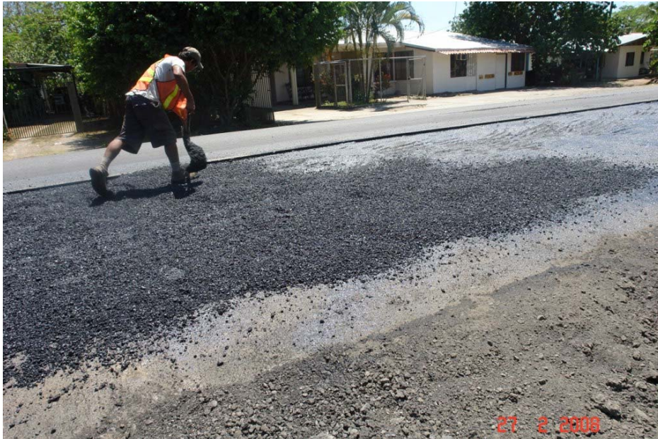
Fotografía 37. Colocación de la primera capa de concreto asfáltico de espesor 1,5 a 2,5 cm.
