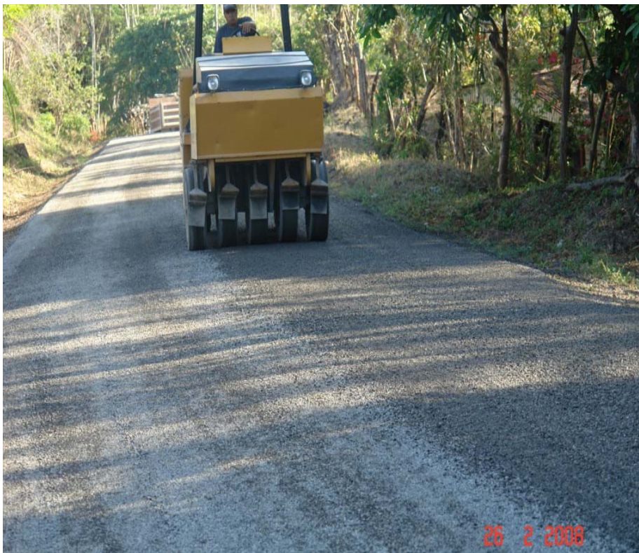
Fotografía 23. Compactación neumático.
