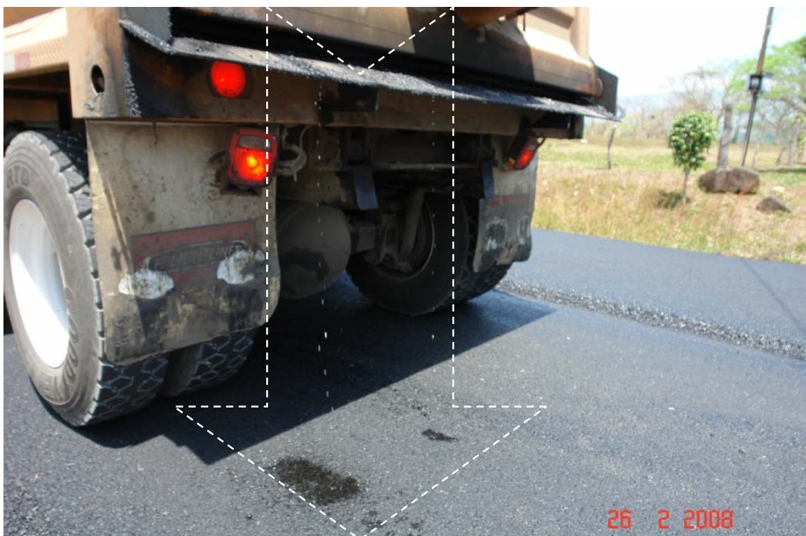
Fotografía 6. Obsérvese agua saliendo de la vagoneta que transporte el concreto asfáltico.
