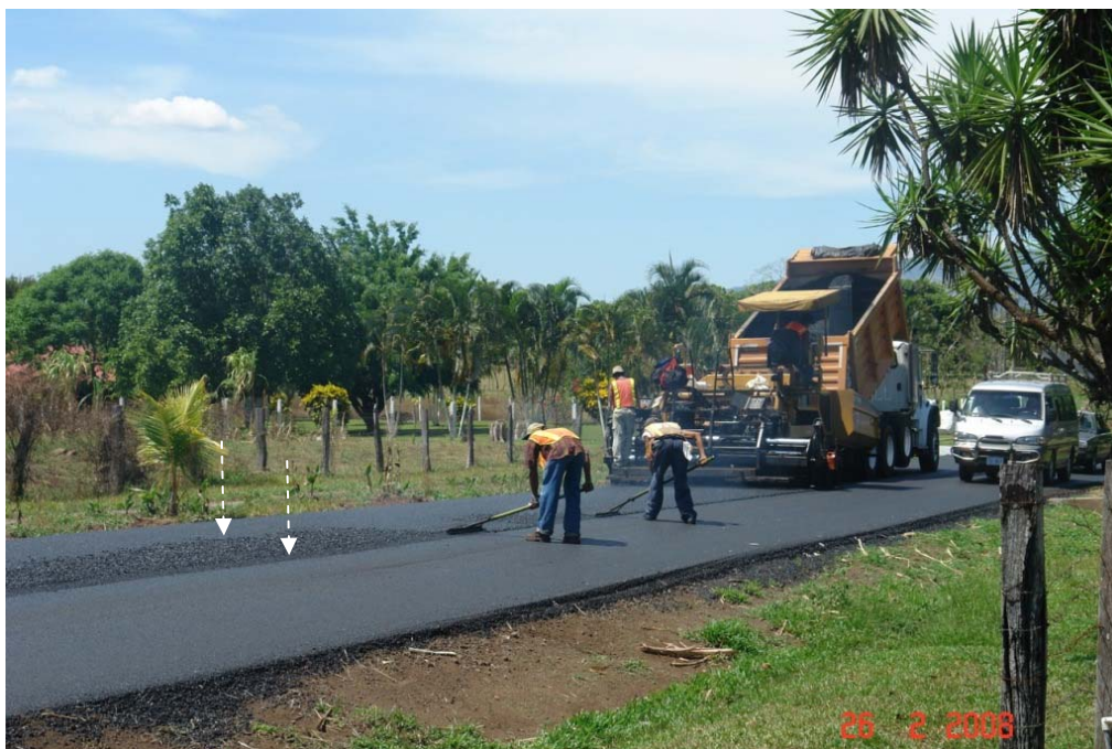
Fotografía 4. La zona de traslape del equipo produce material sobrante que al ser venteado en el carril que se construye modifica la textura homogénea dejada por la pavimentadora.
