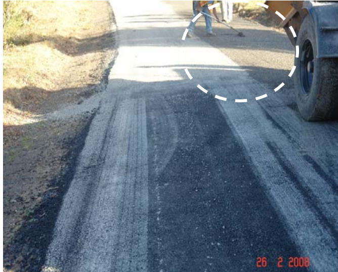
Fotografía 22. Ajustes manuales a la extensión del agregado antes de la compactación.
