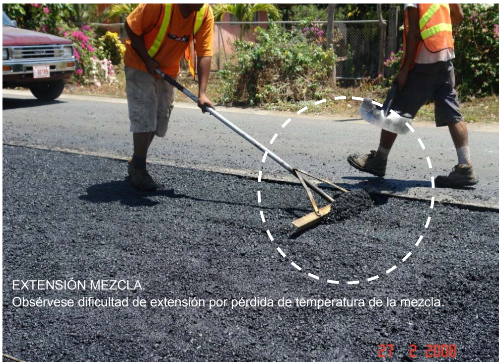
Fotografía 42. Extensión manual de la mezcla asfáltica, la cual se colocará en dos capas.
