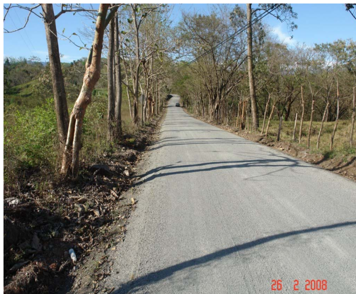
Fotografía 10. Aspecto general de un tramo con tratamiento superficial terminado y no barrido.
