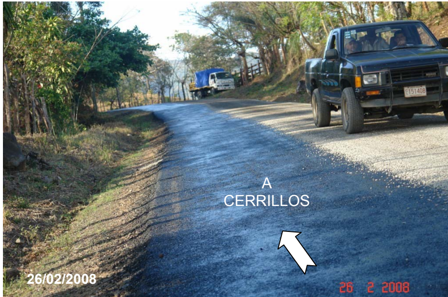
Fotografía 19. Aplicación de la emulsión.
