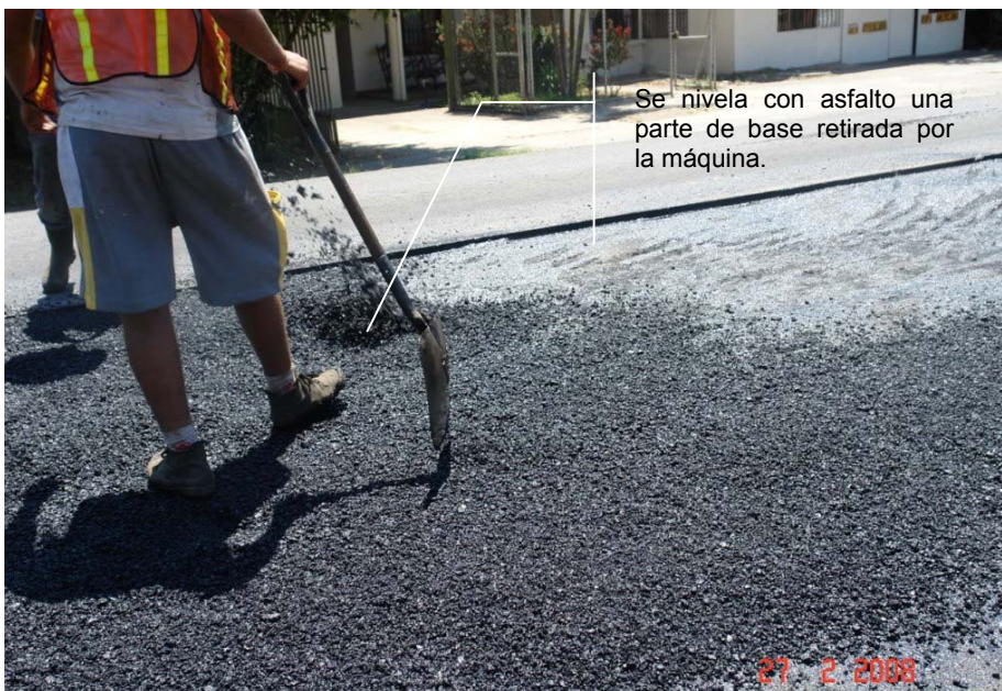
Fotografía 38. Colocación de la primera capa de concreto asfáltico de espesor 1,5 a 2,5 cm. Espesor total promedio compacto 3 a 5 cm
