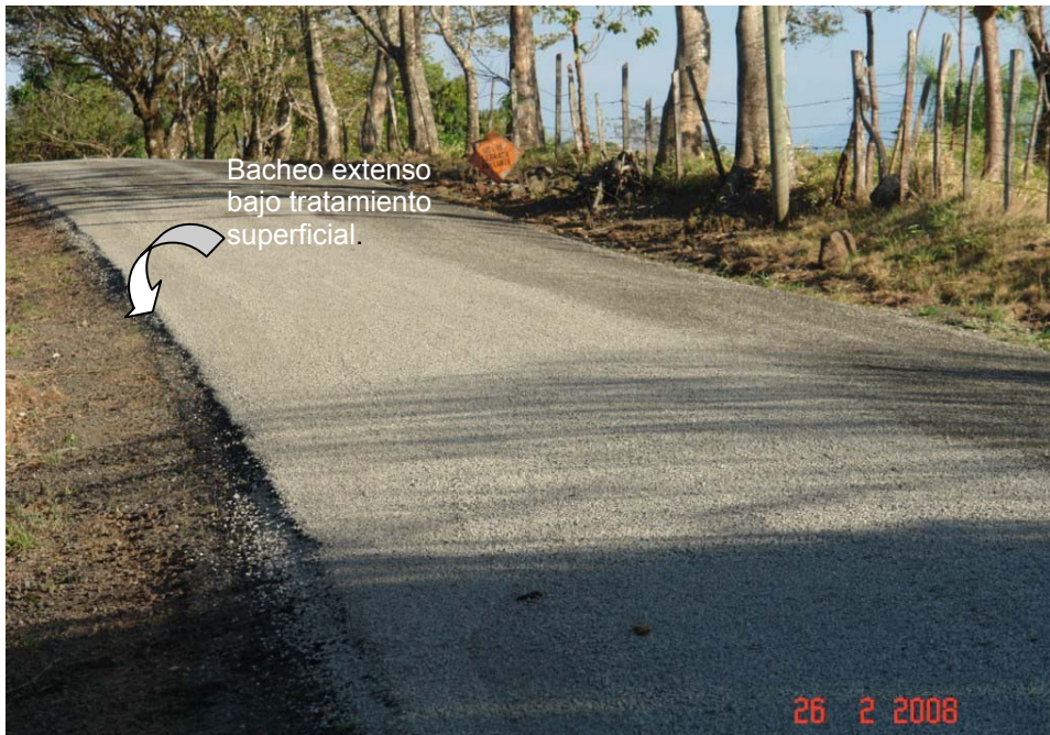
Fotografía 13. Capa asfáltica subyacente al tratamiento superficial
