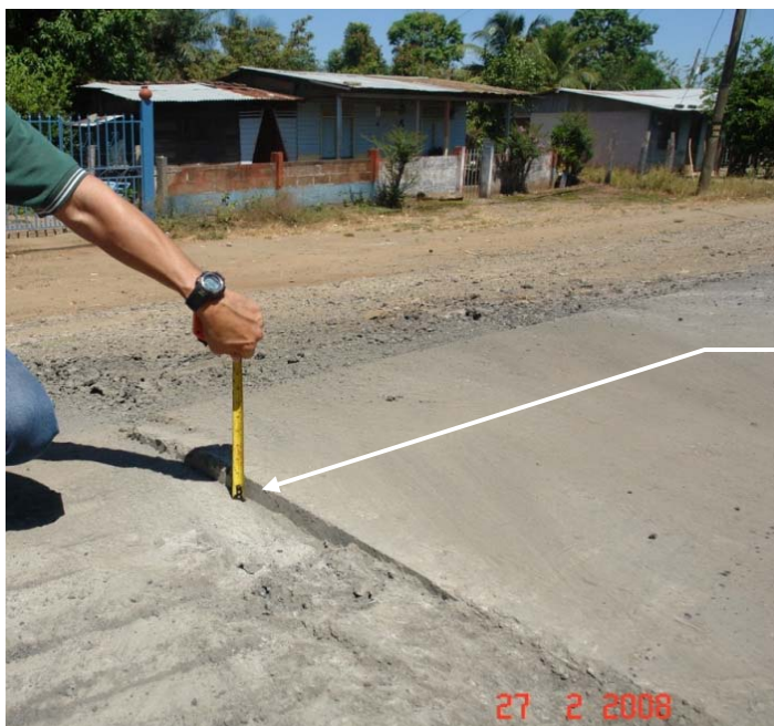
Fotografías 35 y 36. Espesor de bacheo: 3 cm., inferior al tamaño máximo nominal de la mezcla que se coloca.
