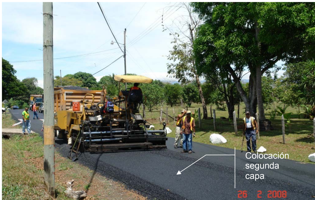
Fotografía 8. Colocación de la segunda capa de concreto asfáltico sobre el carril derecho (Sentido Esparza-Río Jesús María) más de diez días después de la colocación de la primera capa
