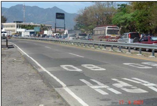
Fotografía 1: Tramo de la Ruta 32 donde se está colocando la barrera tipo Viga Galvanizada.
