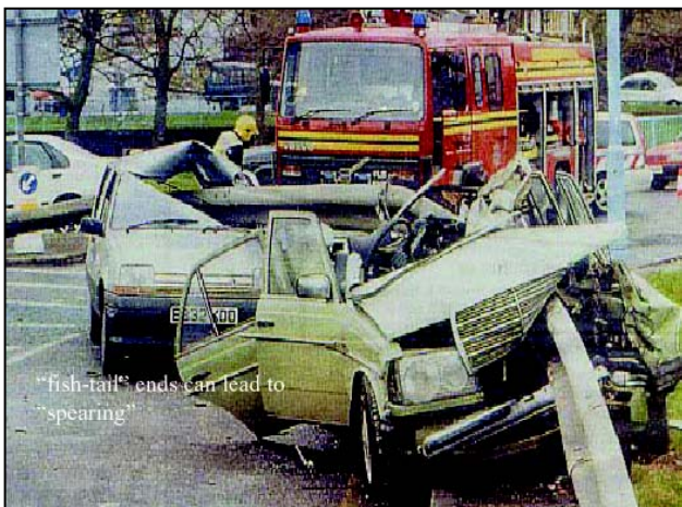
Figura 1: Ejemplo del peligro que representa un diseño inadecuado de la terminación de la viga.
