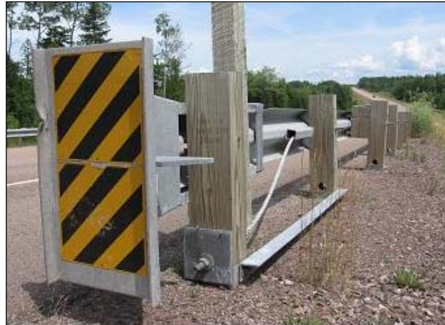
Figura 3: Amortiguador de impacto utilizado en las terminales de los guardavías.
