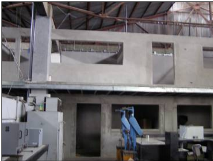
Fotografía 1. Trabajos de remodelación que se están realizando en el laboratorio.
