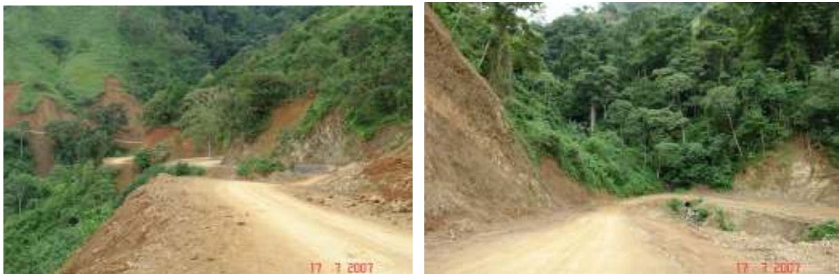
Fotografía No.15 y No.16: Radios de curva "cerradas" en el proyecto.
