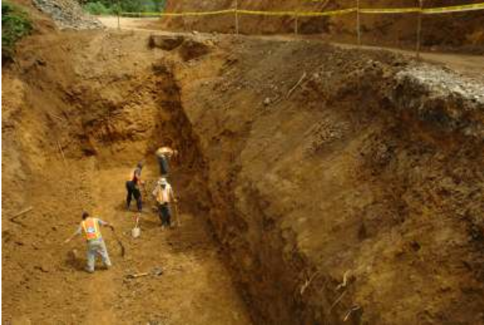
Fotografía No.6: Se puede notar que se está preparando el terreno para la colocación de un muro de gaviones en un sitio donde se produjo un deslizamiento donde ya se había construido un cabezal para alcantarilla.
