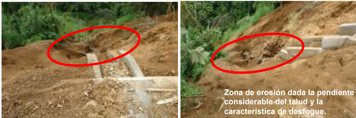
Fotografías No.11 y No.12: Detalles observados en los desfogues de las alcantarillas construidas.
