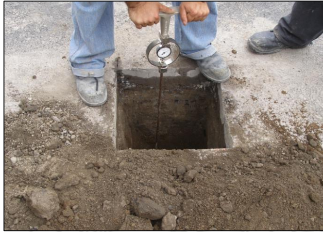
Figura 27. Prueba de CBR en sitio.
