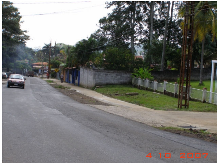
Fotografía 8. Demarcación horizontal casi invisible sobre la Ruta Nacional N° 3, sección Manolos- San Mateo a. Se observa como la demarcación es casi invisible en algunos tramos de la ruta b. En otros tramos la demarcación está totalmente borrada.
