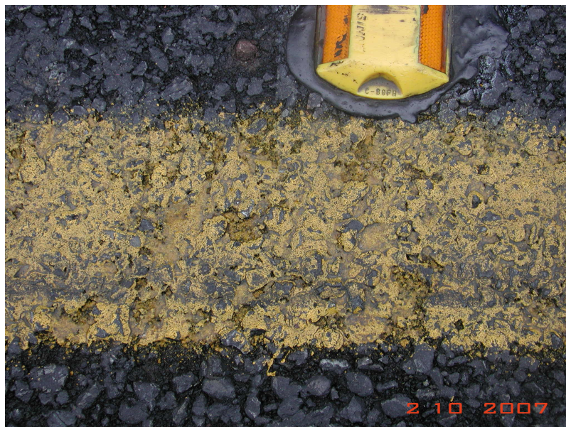
Fotografía 2. Demarcación desgastada sin propiedades de retroreflexión sobre la Ruta Nacional N° 2, sección La Lima-San isidro. a y b. El desgaste que presenta la demarcación permite ver la superficie asfáltica.
