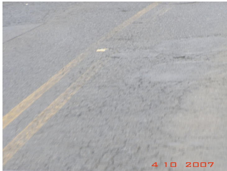
Fotografía 7. Demarcación horizontal sobre deterioros en la Ruta Nacional N° 3, sección Manolos- San Mateo a y b. Se observa demarcación con desgaste avanzado realizada sobre deterioros superficiales.
