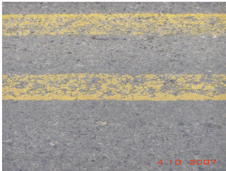
Fotografía 6. Deterioro que muestra la demarcación horizontal sobre la Ruta Nacional N° 3, sección Manolos- San Mateo a. Desgaste que muestra la demarcación horizontal. b. El desgaste de la demarcación permite ver el pavimento asfáltico.
