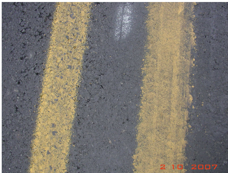
Fotografía 4. Demarcación horizontal opaca sobre la Ruta Nacional N° 2, sección La Lima-San isidro a. Se observa que la demarcación presenta opacidad. b. Se aprecia una diferencia clara entre las líneas de demarcación de carril.
