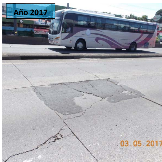
F8: Puente Juan Pablo II . Agrietamiento y bacheo en la losa de aproximación del puente en la superestructura con dirección Alajuela-San José, del sector de San José
