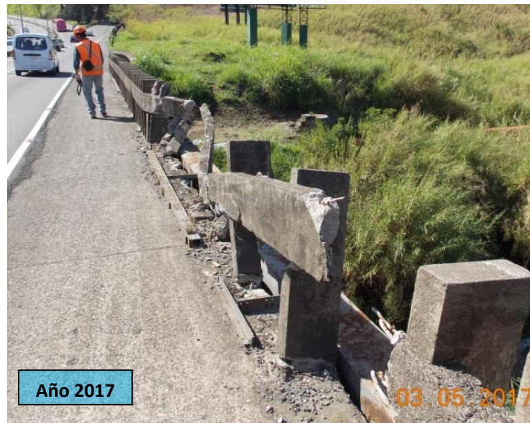
F3: Puente sobre el río Torres. Faltantes por impacto en la barrera vehicular en el sentido Alajuela-San José
