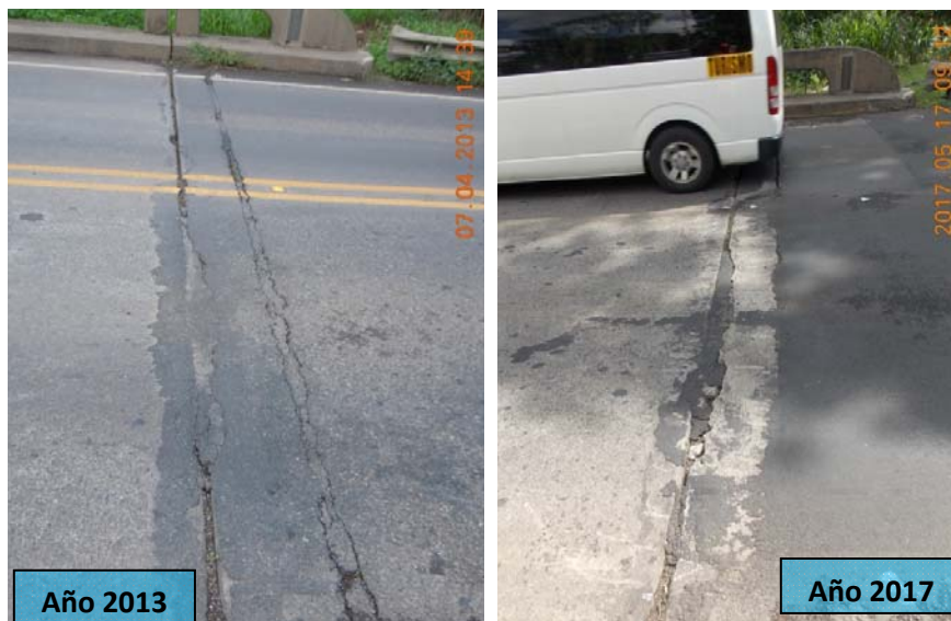
F43: Puente sobre el río Grande (km 47+640). Incremento del deterioro en la junta de expansión y señalización horizontal entre julio del 2013 y mayo del 2017 (acceso en dirección a Alajuela)
