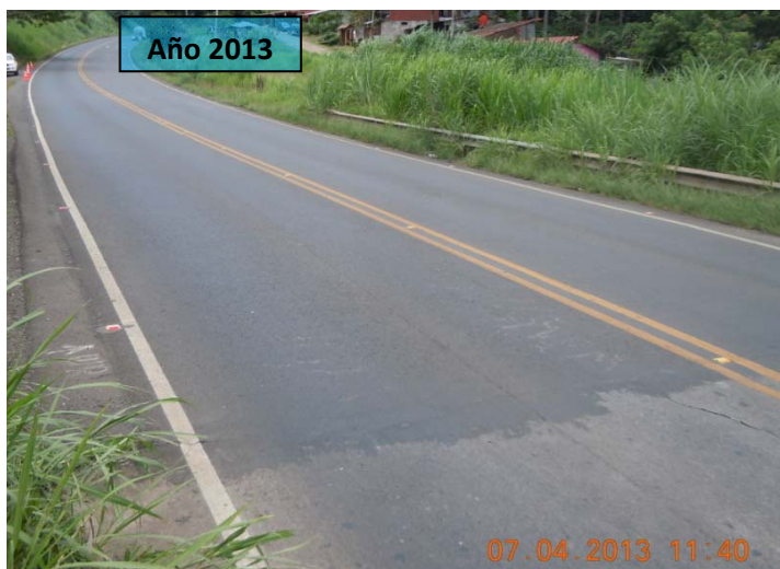
F52: Puente sobre el río Grande (km 54+370). Incremento del deterioro en el pavimento del acceso entre abril del 2013 y mayo del 2017 (acceso en dirección a Alajuela)
