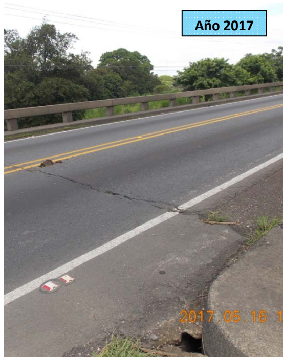
F25: Puente sobre el río Ciruelas. Junta de expansión cubierta de asfalto, sobrecapa de asfalto sobre la losa y evidencia de eflorescencia en tablero
