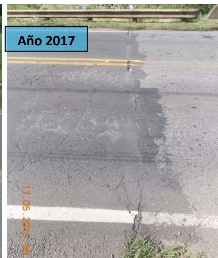
F52: Puente sobre el río Grande (km 54+370). Incremento del deterioro en el pavimento del acceso entre abril del 2013 y mayo del 2017 (acceso en dirección a Alajuela)
