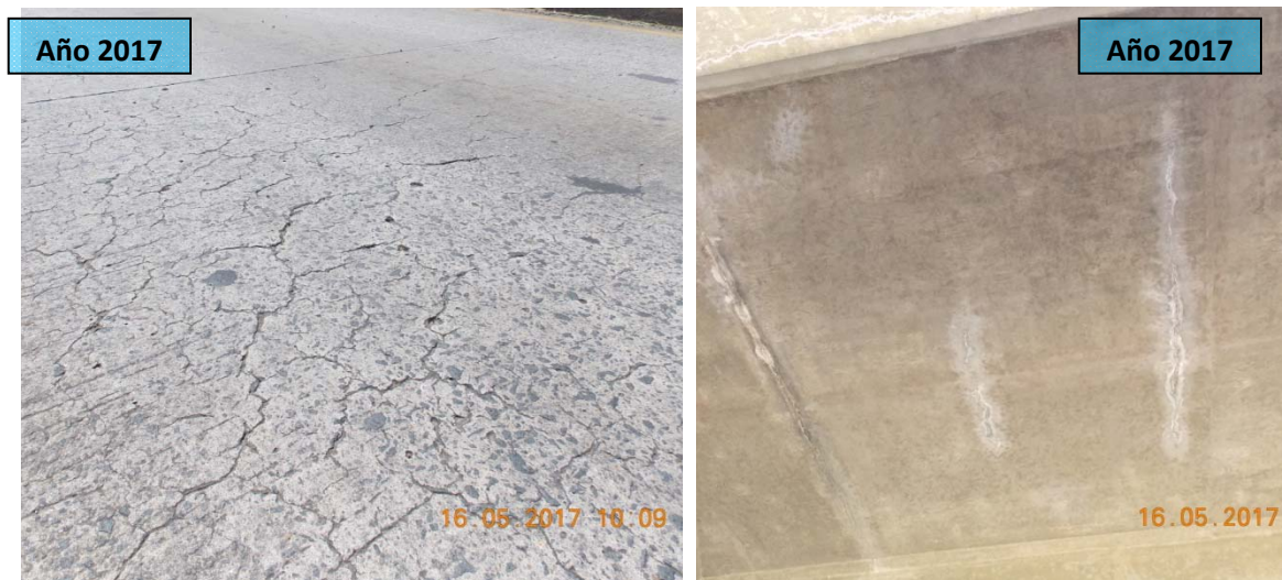
F23: Paso Superior Aeropuerto (Radial F.O). Agrietamiento en dos direcciones y eflorescencia en el tablero del puente
