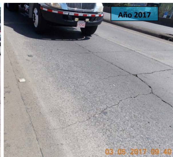
F8: Puente Juan Pablo II . Agrietamiento y bacheo en la losa de aproximación del puente en la superestructura con dirección Alajuela-San José, del sector de San José
