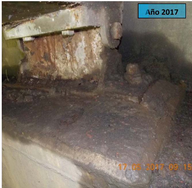
F47: Puente sobre el río Grande (km 47+640). Deterioro por corrosión en apoyos, además acumulación de escombros en el entorno del apoyo e insuficiente longitud de apoyo
