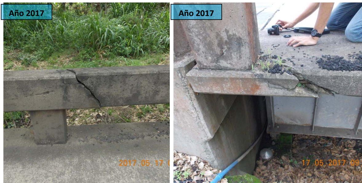
F42: Puente sobre el río Grande (km 47+640). Daños por impacto vehicular en la barrera de contención del puente
