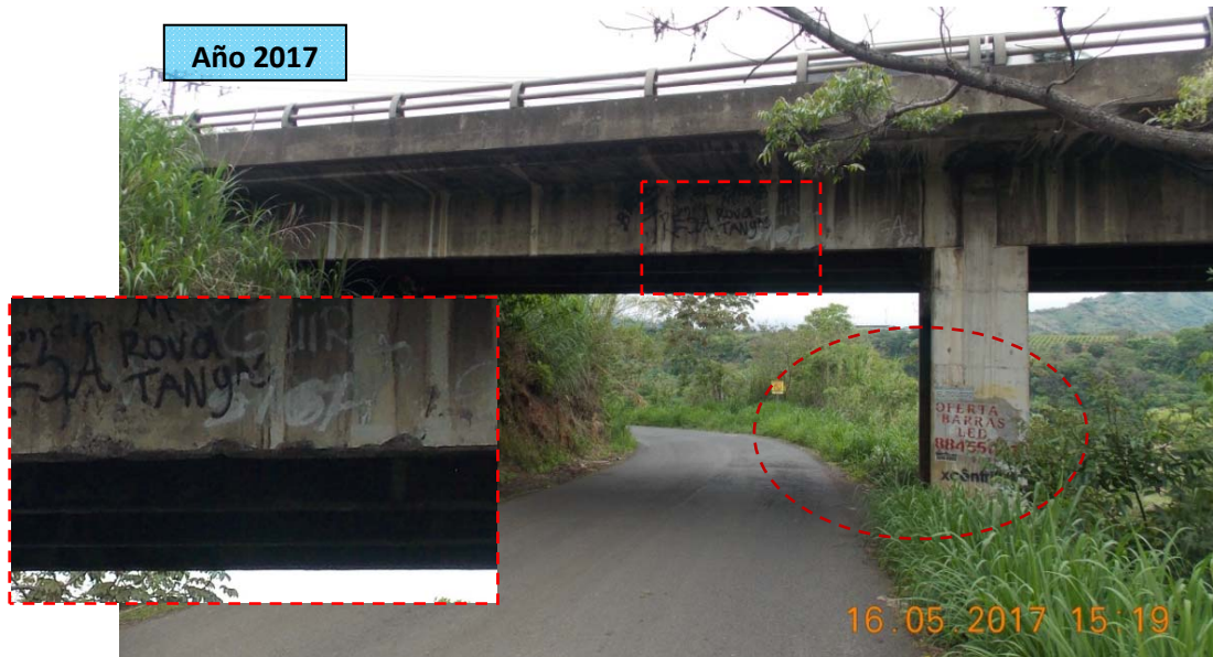
F41: Puente Rafael Iglesias (sobre el río Colorado). Faltante de barrera de protección a las pilas (acceso a Grecia), expuestas a impacto vehicular en la ruta nacional 716. Superestructura evidencia daño por impacto vehicular
