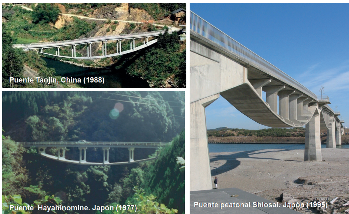
Figura 1. Puentes con forma estructural similar a la del puente sobre el río Colorado: Puente Taojin (Sohu Media Platform, 2015), Puente Hayahinomine (Japan Concrete Institute, 1996), Shiosai (Tawashi2006, 2007)
