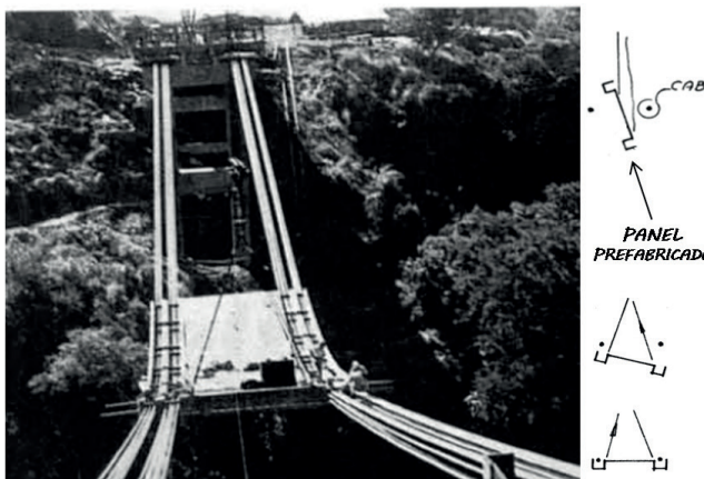
Figura 5. Proceso de colocación de paneles prefabricados de la losa inferior del tramo central. (Esquema modificado de los planos del puente (MOPT, 1968) y fotografía tomada de Kulka, 1973).
