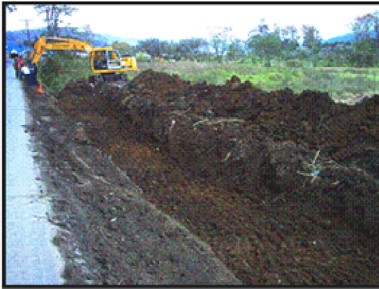
Fotografías No.3 y 4: Detalle de las labores observadas de excavación y posterior relleno con el material extraído de la ruta No.2, fotografías tomadas el 7 de marzo de 2006.
