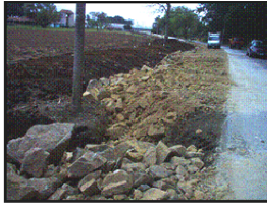
Fotografías No.3 y 4: Detalle de las labores observadas de excavación y posterior relleno con el material extraído de la ruta No.2, fotografías tomadas el 7 de marzo de 2006.
