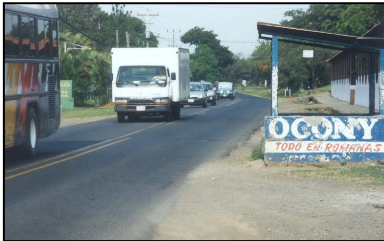
Fotografía 15 Parada de bus al lado de la carretera sin bahía de buses
