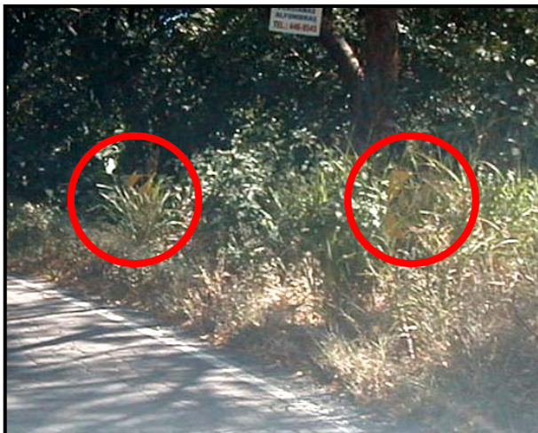
Fotografía 7 Delineadores cubiertos por la maleza
