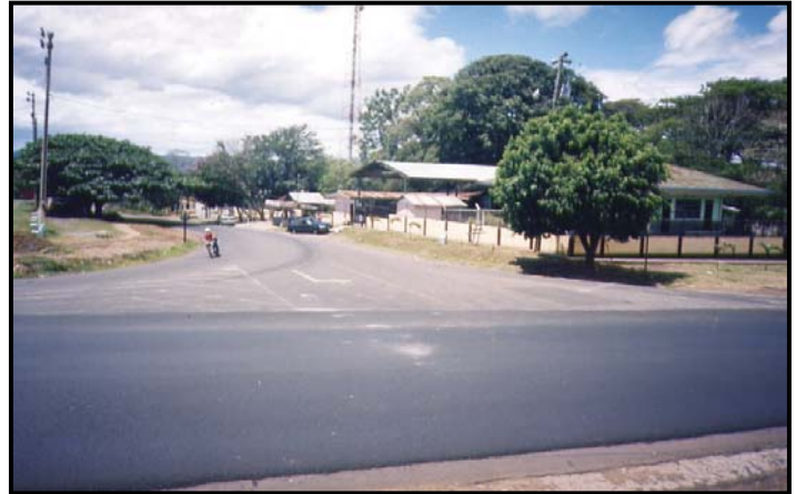
Fotografía 27 Intersección Turrúcares Demarcación horizontal deficiente
