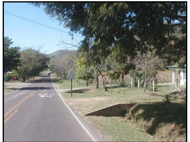
Fotografía 12 Estructura de concreto sobre alcantarilla de entrada a propiedad lateral
