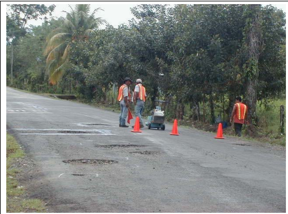
Fotografía No. 6: Cuadrilla de corte de baches
