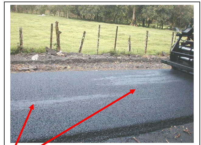
Fotografías No. 4 y 5: Zonas con presencia de humedad.
