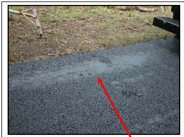
Fotografías No. 4 y 5: Zonas con presencia de humedad.
