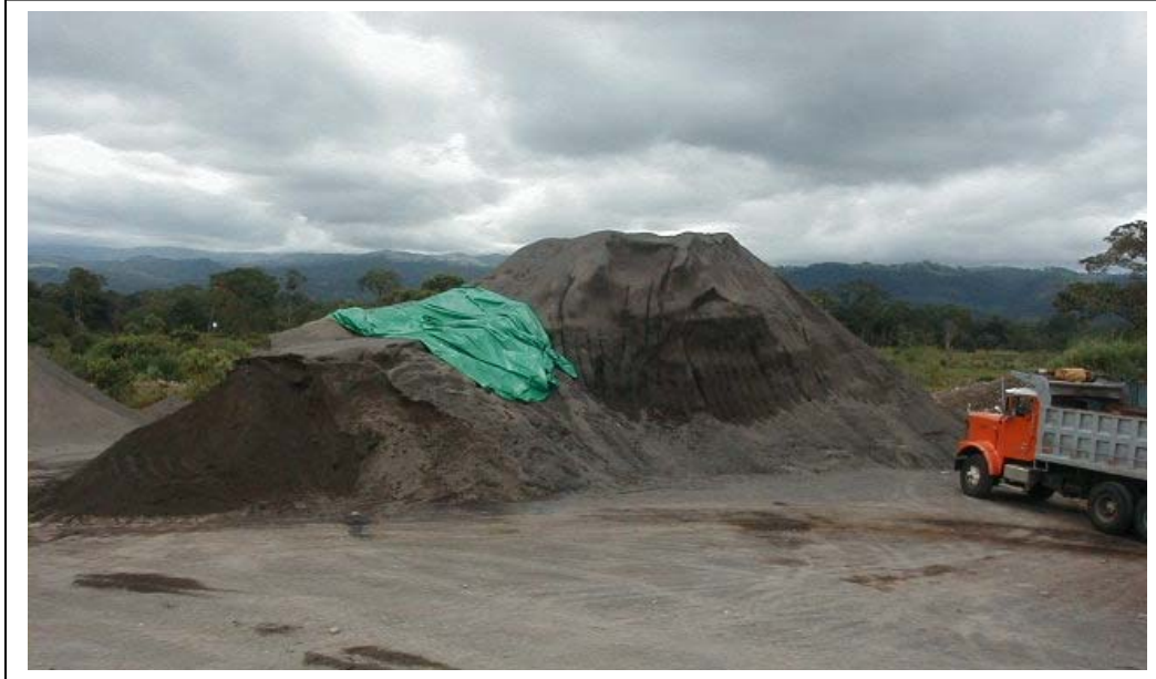
Fotografía No. 13: Deficiente cobertura de los apilamientos.
