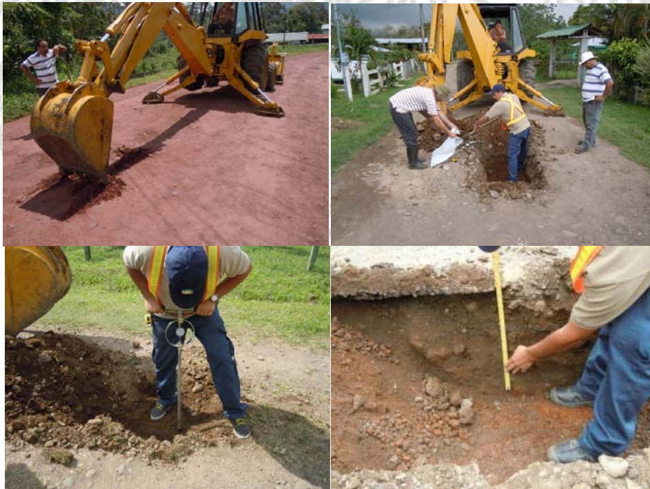
Figura 7. Proceso de excavación de los sondes a cielo abierto.
